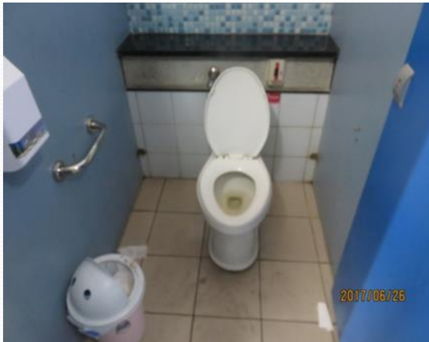
安全扶手-座式廁間
