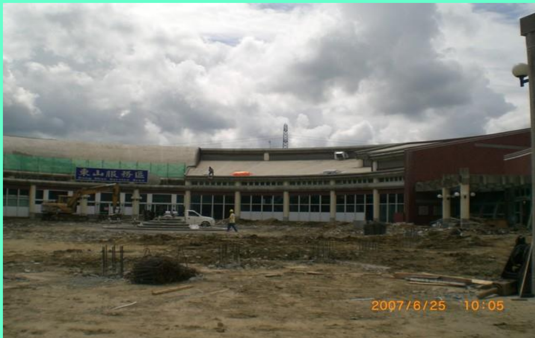
東山服務區施工
