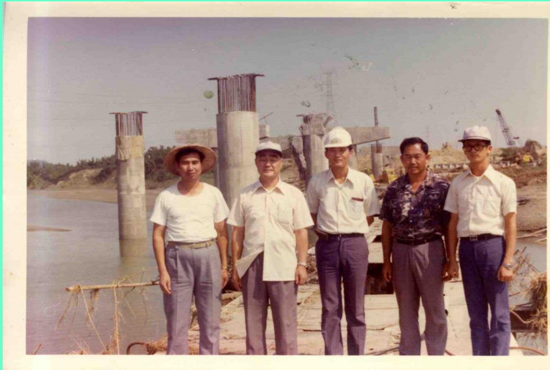
第 1 任處長劉鍾翰先生巡視工地 (左 2)
