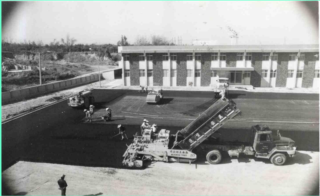
南區工程處舊大樓施工
