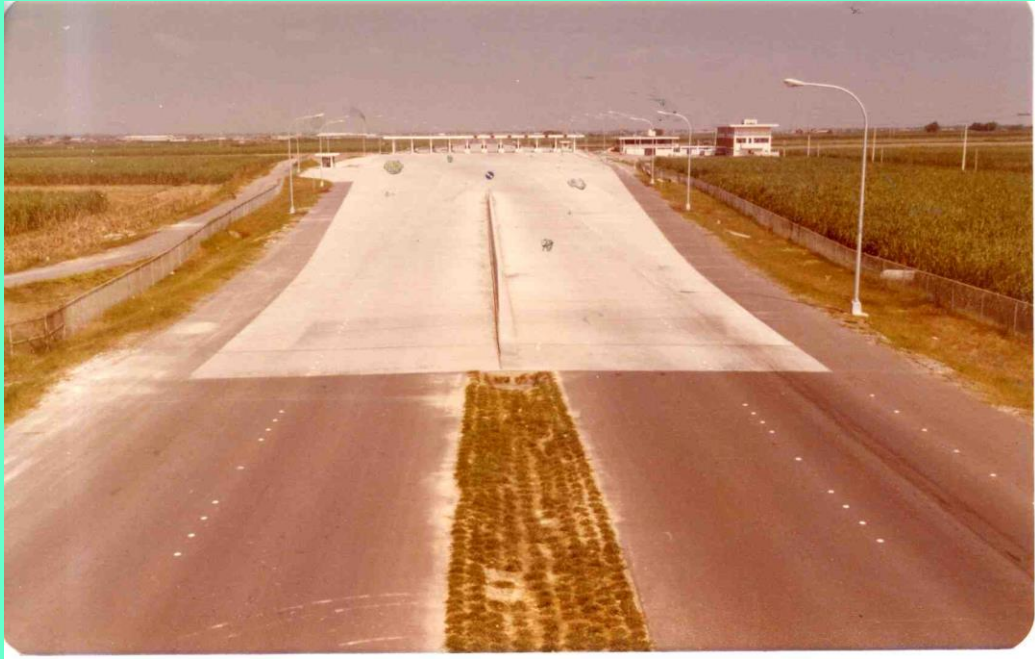
岡山收費站施工中
