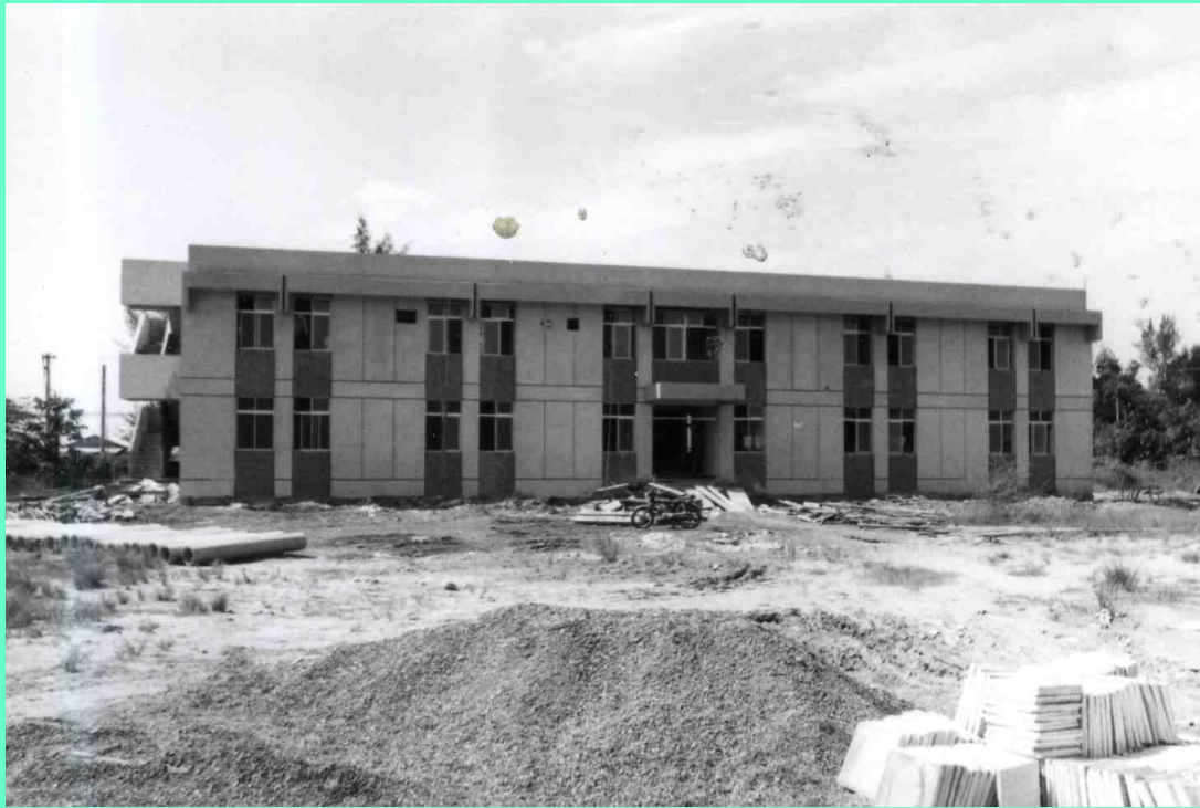
南區工程處舊大樓施工
