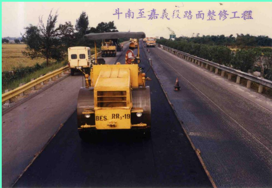
三輪壓路機滾壓
