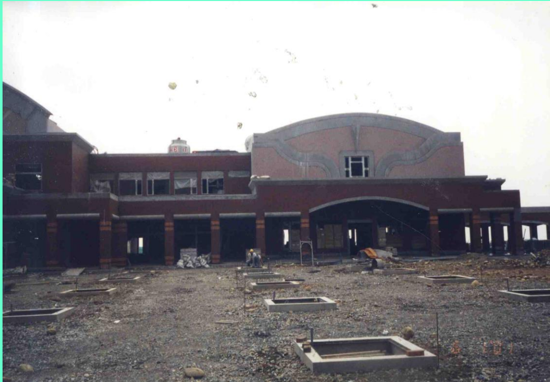
古坑服務區施工
