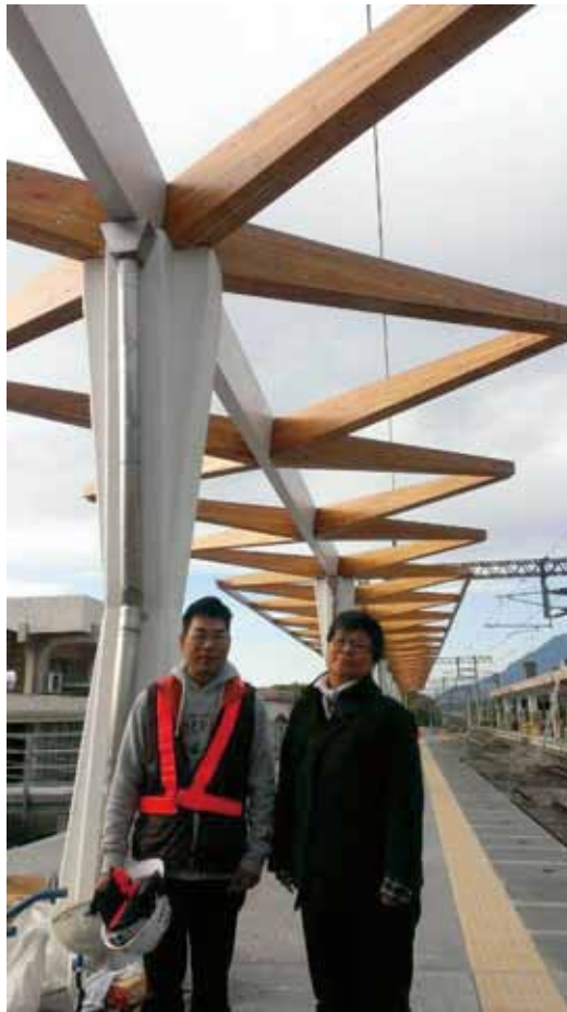
* 右：樂靜建築師巡視新城車站工地
