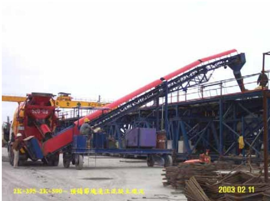
圖 4 預鑄節塊澆置混凝土現況
