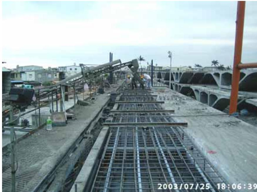
圖 3 預鑄節塊澆置工作平台
