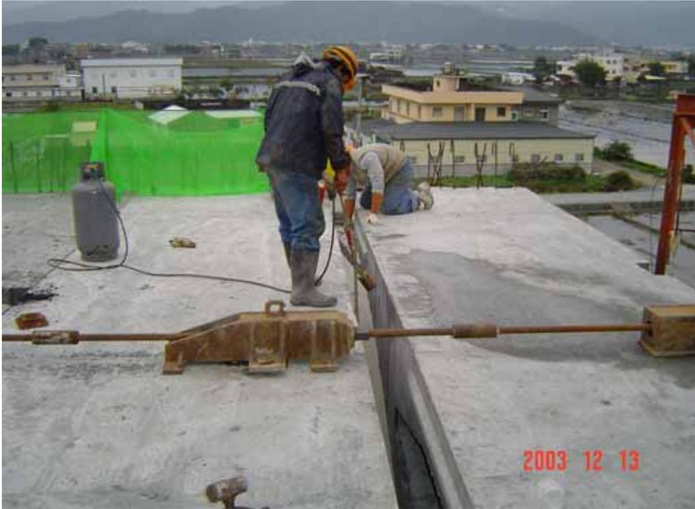
圖 8 接合面處理及塗抹 epoxy
