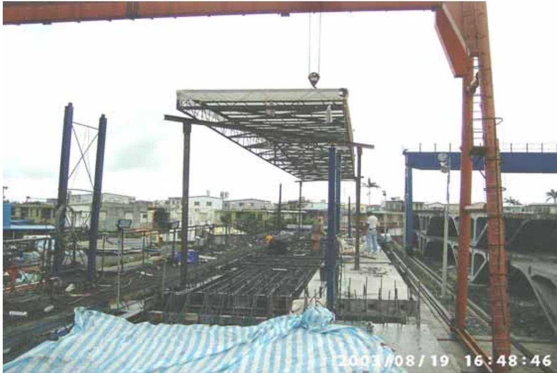
圖 1 遮雨棚架由天車吊運安裝
