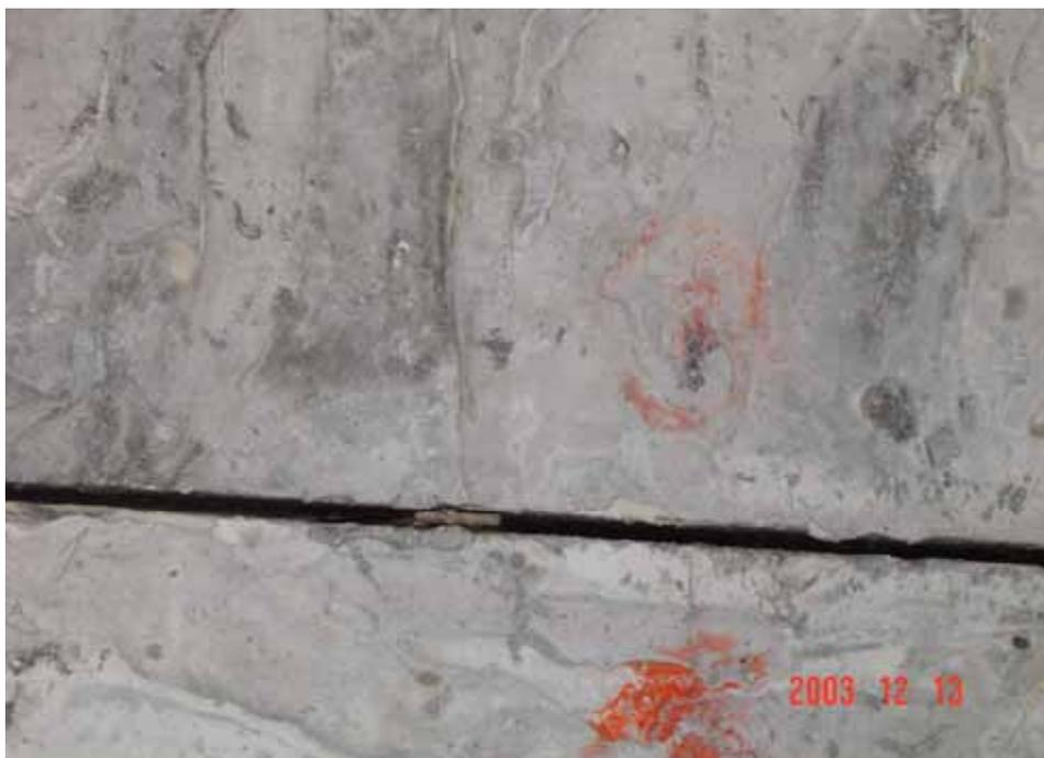
圖 11 薄墊片塞入交接處隙縫
