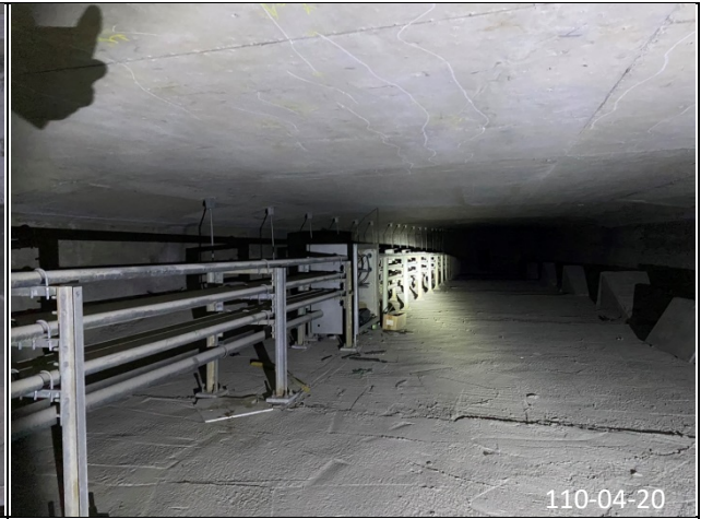
和美交流道匝道八高架橋環境
