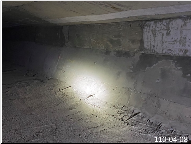
和美交流道匝道七高架橋環境
