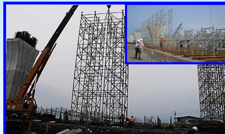
支撐架地面組立完成後吊裝
