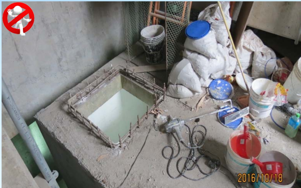
局限空間內使用有機溶劑作業(防水塗劑)，未進行通風換氣
