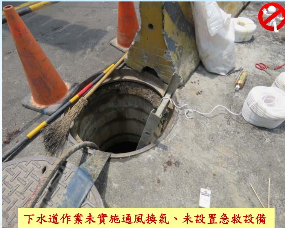
局限空間內使用有機溶劑作業(防水塗劑)，未進行通風換氣
