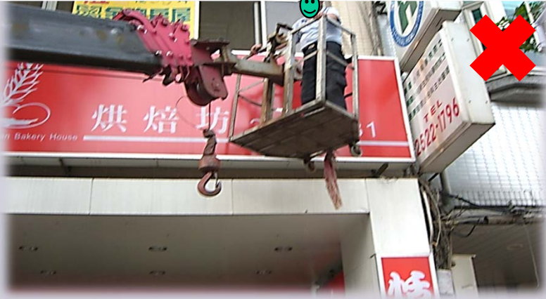
移動式起使用於乘載勞工從事作業
