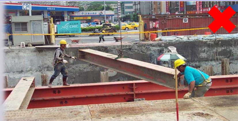
長型吊掛物採取單索吊掛且無控索
