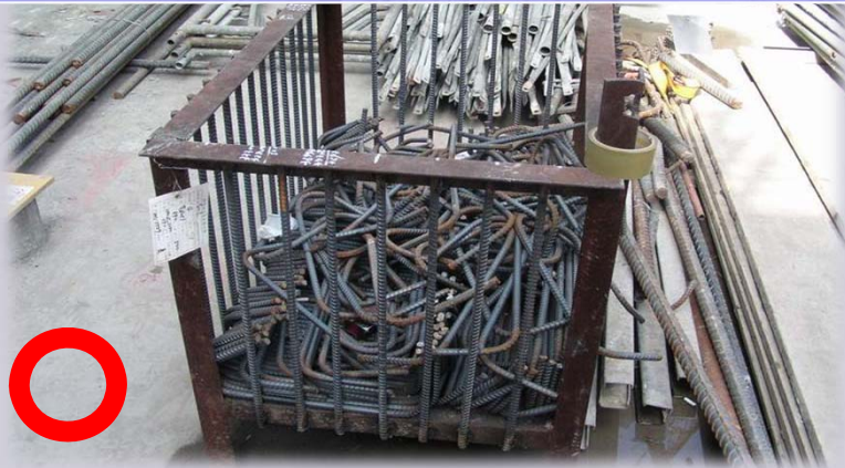
載具使用足夠強度吊籃（吊框）
