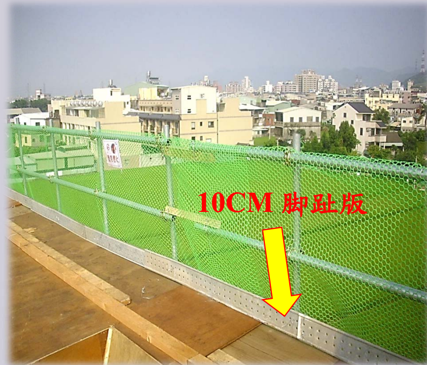
護欄設置腳趾板
