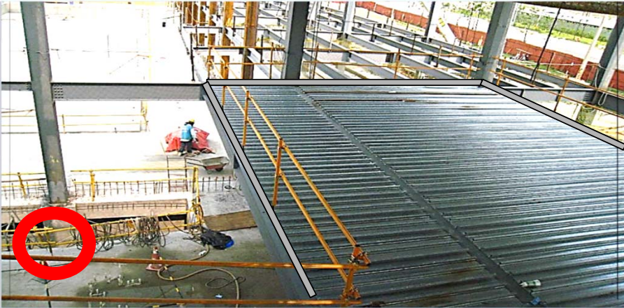
鋼承板完成後 開放邊線設置GIP鋼管護欄
