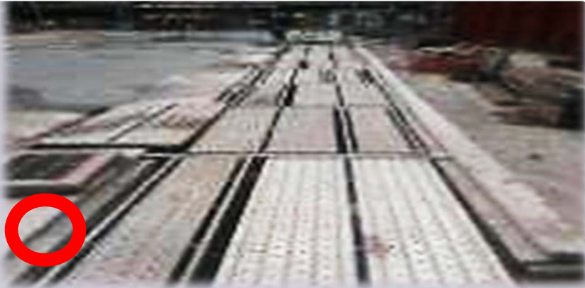
導溝開口設置護蓋
