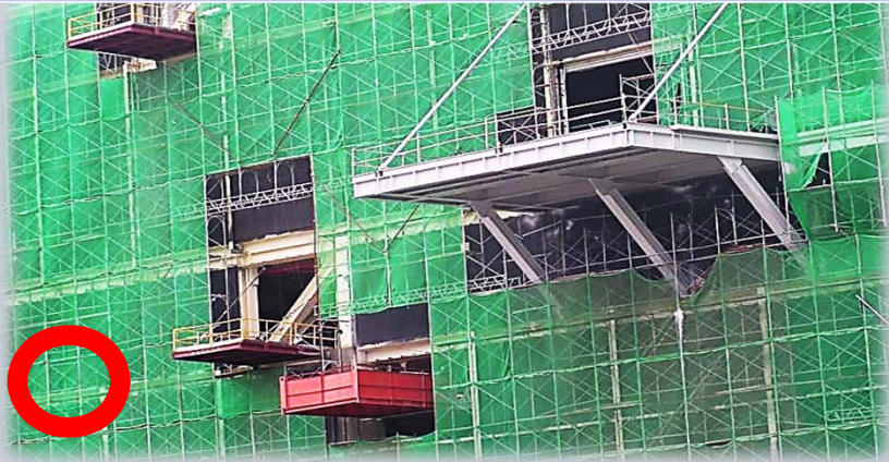
依吊裝之設備設置足夠強度吊裝平台
