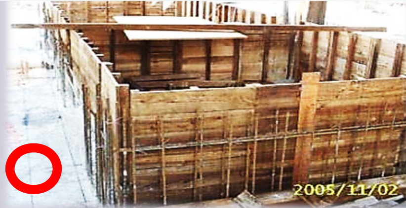
電梯井組模時，將模板提高90cm為臨時防護
