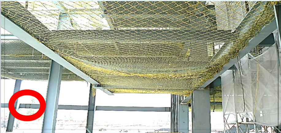
鋼構組配作業前預置張掛安全網、覆網
