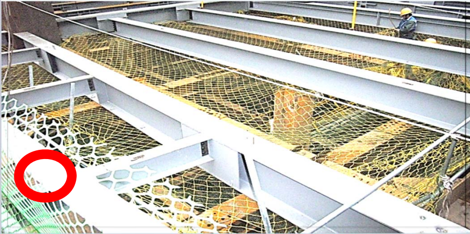
鋼構組配作業前預置張掛安全網、覆網
