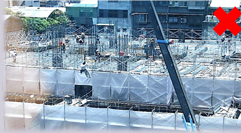
移動式起重機使用於吊升人員作業
