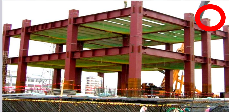
落差超過兩層樓或高度超過7.5公尺，滿鋪鋪設安全網
