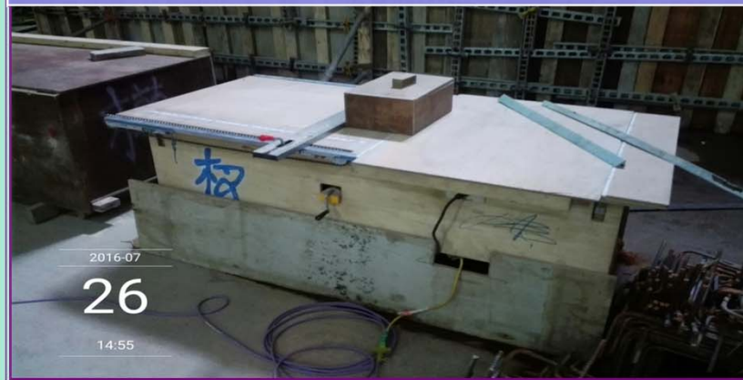
電動切割機具臨時保護措施
