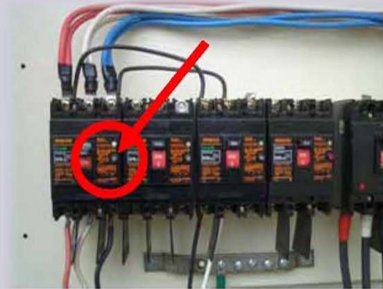
三相式無熔絲開關內含 漏電斷路器
