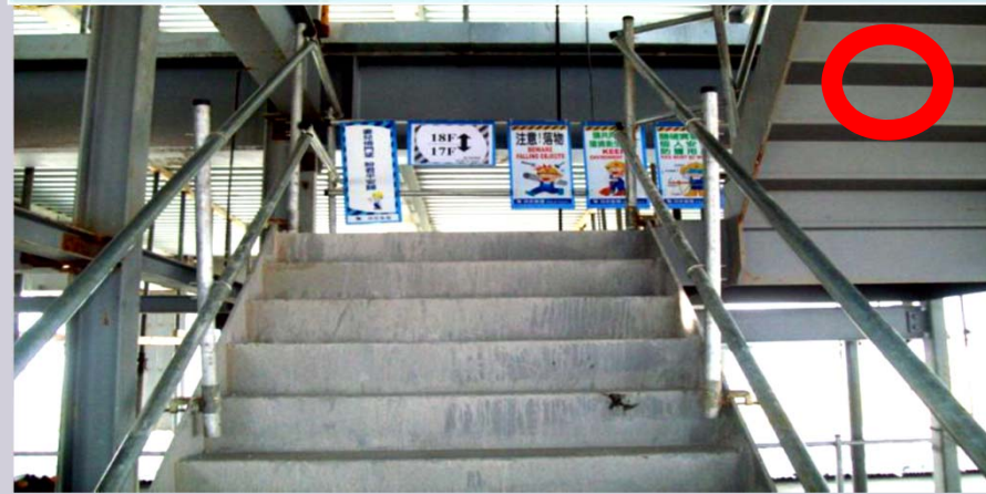
鋼樓梯兩側設置安全護欄
