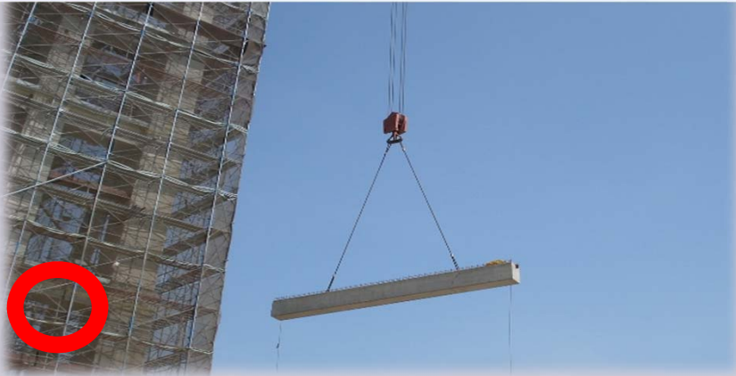
長型吊掛物採取双索吊掛並加控索
