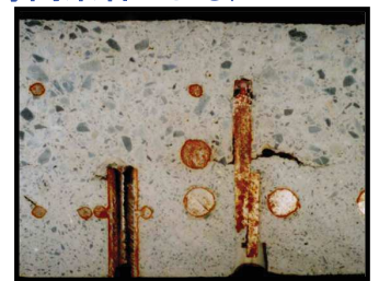
高流動モルタル逆打ち工法
