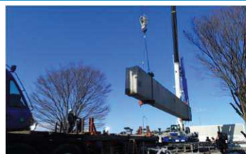
PC橋主桁の撤去
