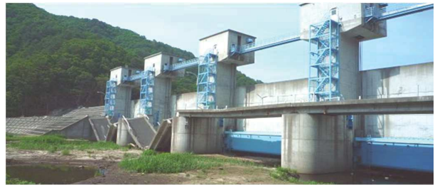
耐荷力の大半が喪失したPC橋
