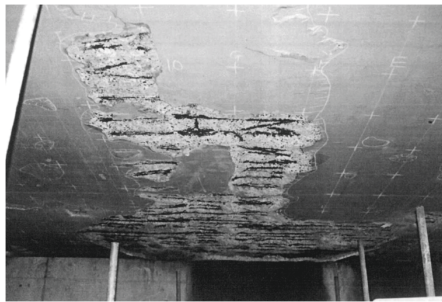
RC中空床版橋下面劣化
