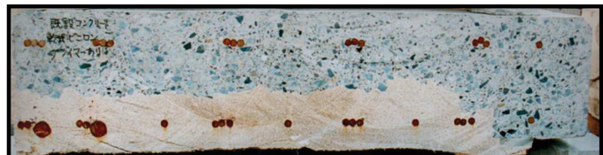
吹付け工法1(専門業者による)
