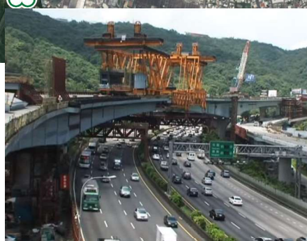
懸臂吊裝工法
