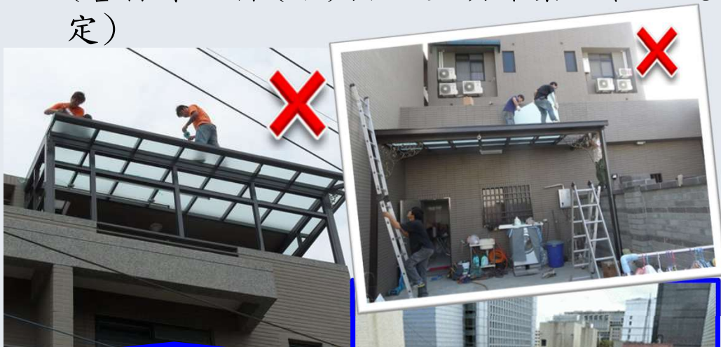
屋頂(雨遮)作業
