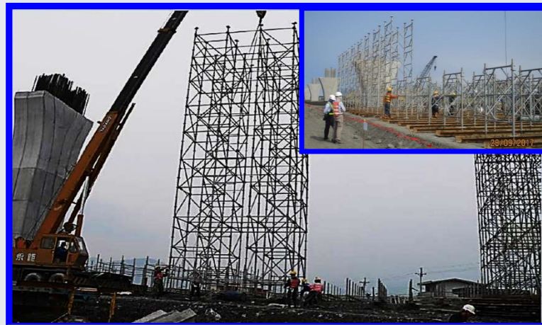
支撐架地面組立完成後吊裝
