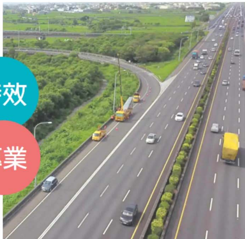
戰備道交通管制及設施拆除復原工程
