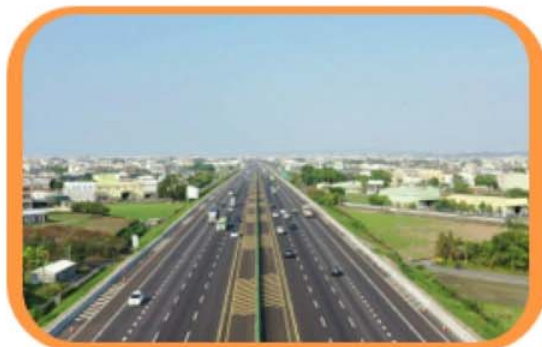
外側護欄設置
