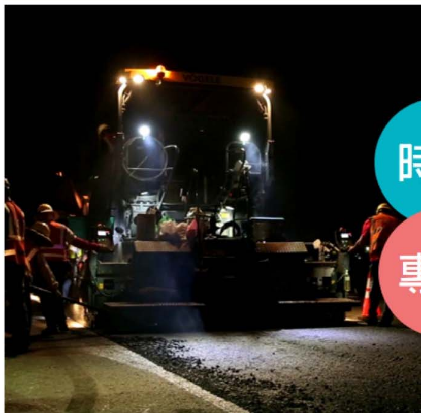
路面整修工程
