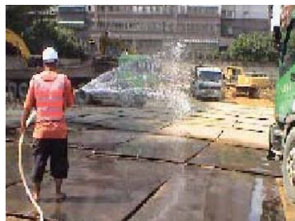
裸露區域覆蓋及灑水
