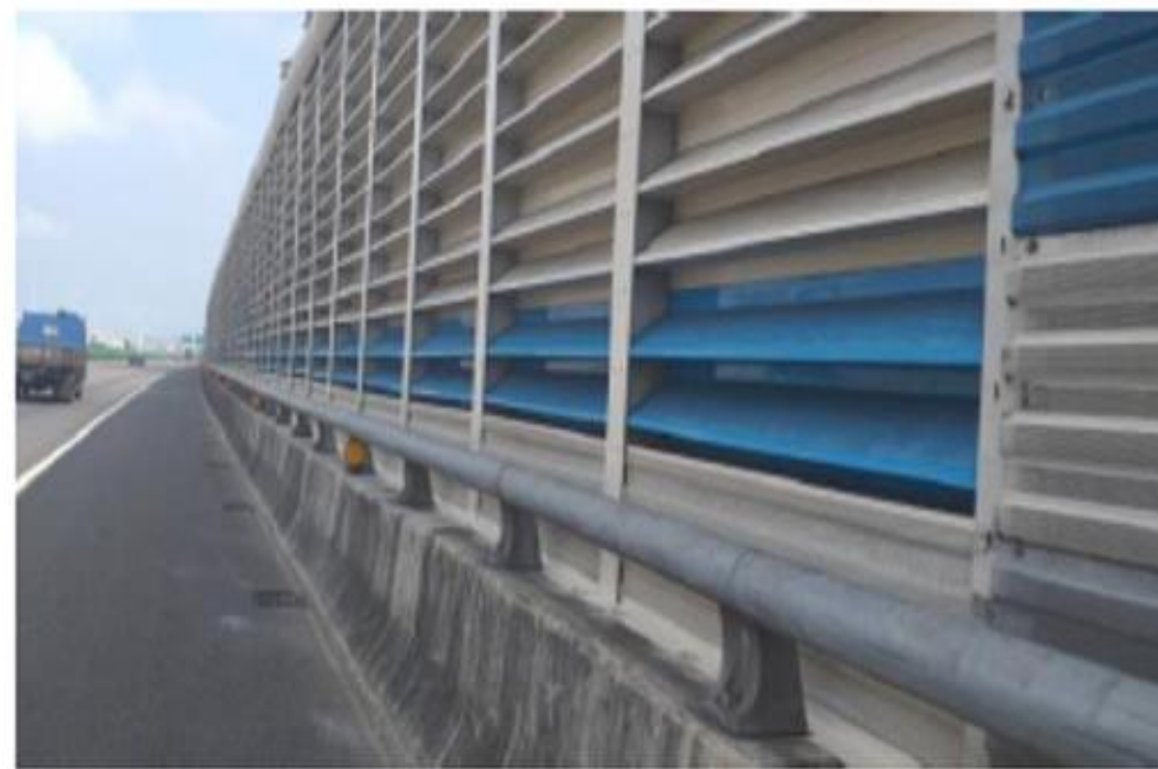
直立式隔音牆楔形吸音板
