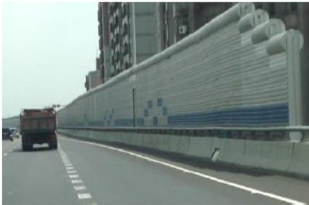
直立隔音牆(支柱包覆)設頂端吸音裝置
