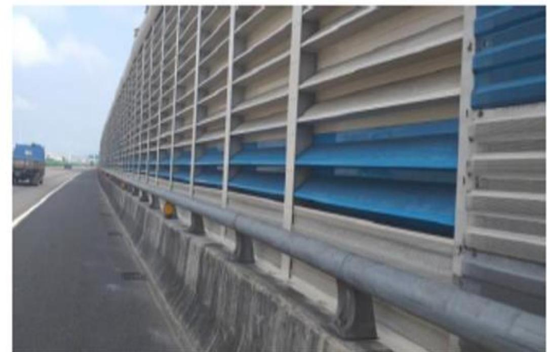
直立式隔音牆楔形吸音板
