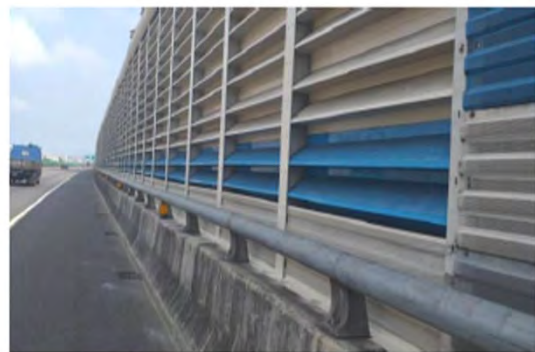
直立式隔音牆楔形吸音板
