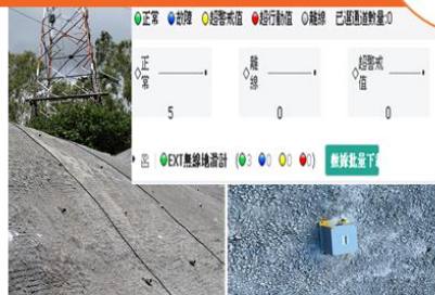
邊坡監測系統
