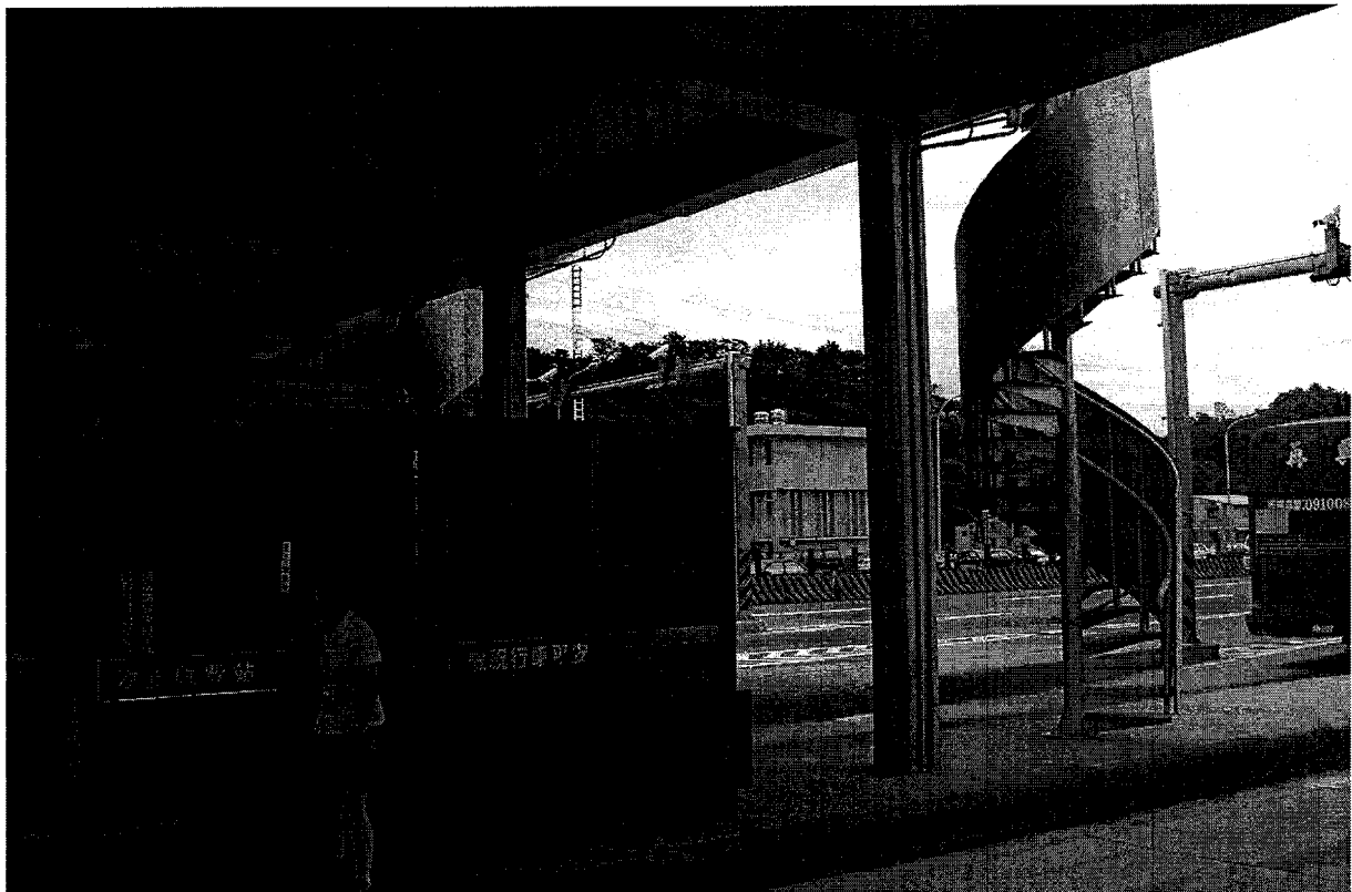
汐止收費亭梁柱
