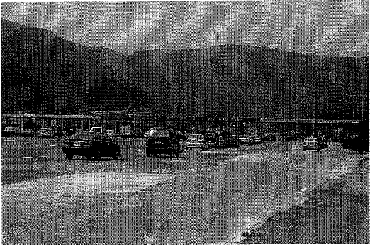
泰山收費亭外觀全貌
