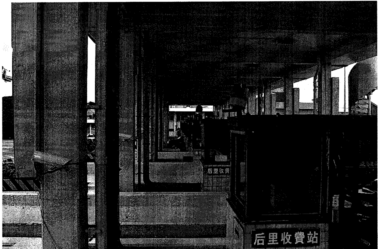
后里收費站柱梁
