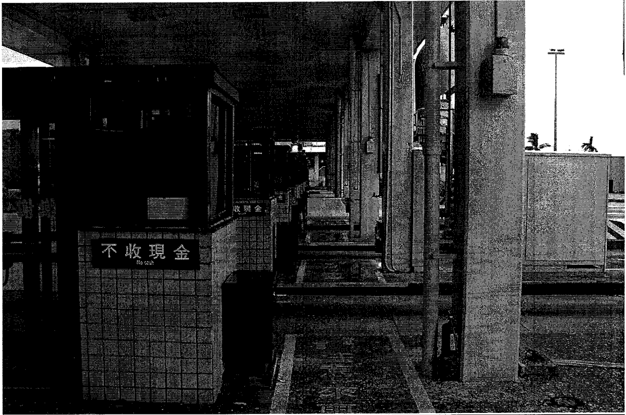
后里收費站柱梁
