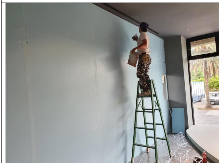
清水展場進行木作展架補土及油漆上色作業
