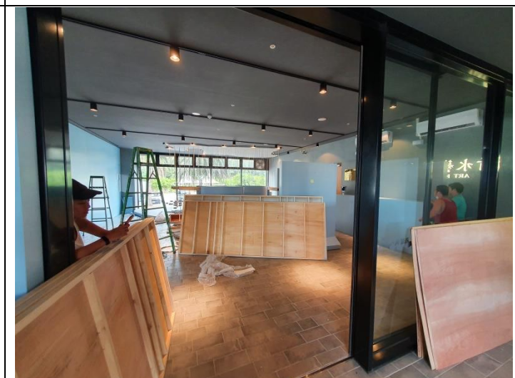
清水展場木工進行組裝與定位展具作業
