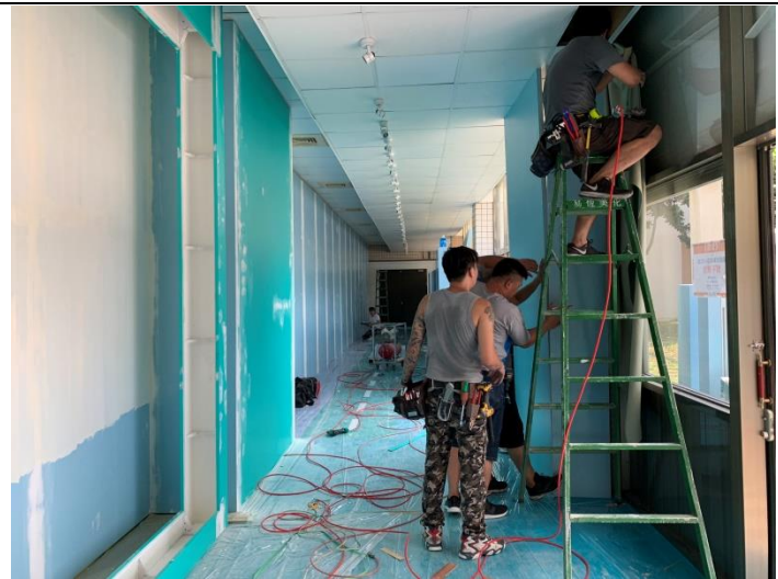
泰安展場電工配線中
