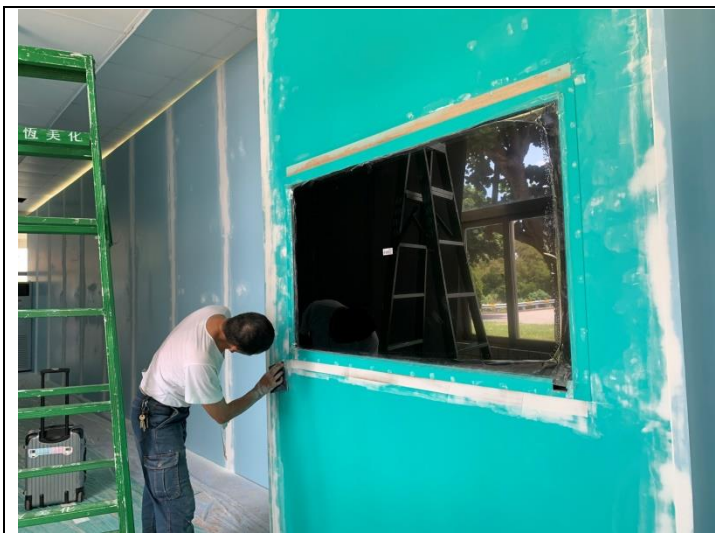
泰安展場木工量製框架尺寸並裝設液晶螢幕
