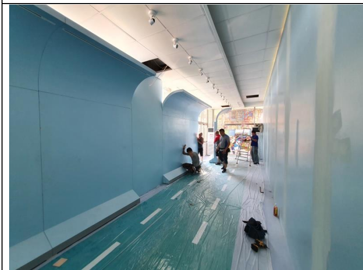
泰安展場木工進行組裝與定位展具作業
