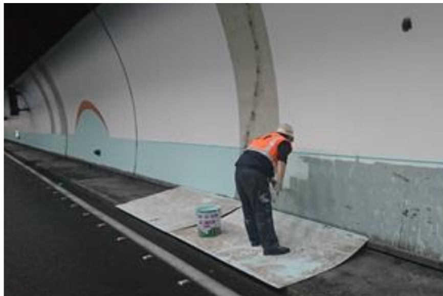
當天施作隧道油漆 作業
