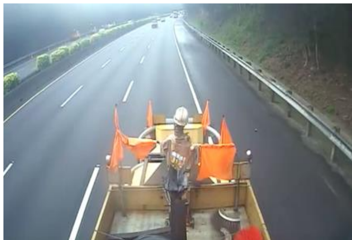
緩撞車切換車道後 仍有約1公里車距 仍遭後車追撞
