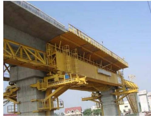
支撐先進工法橋梁工作車推進施工
