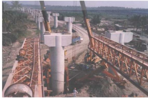
支撐先進工法橋梁支撐鋼架吊裝、拆除作業
