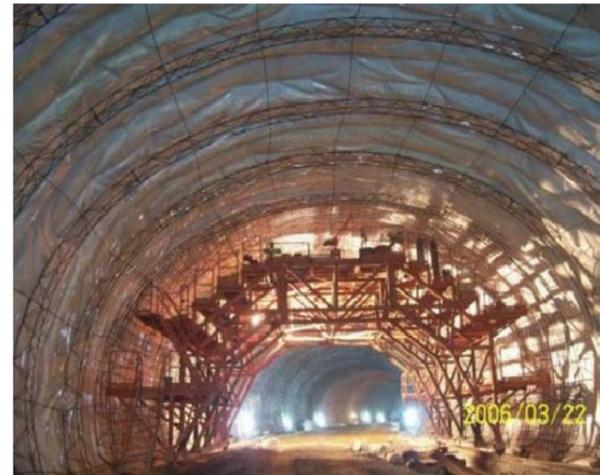
1. 5M以上鋼筋架構築，施工前應依結構力學原理妥為設計，並繪製施工圖且執行自動檢查。
