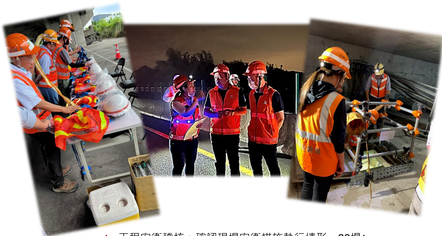
▲ 工程安衛稽核：確認現場安衛措施執行情形，20場↑
