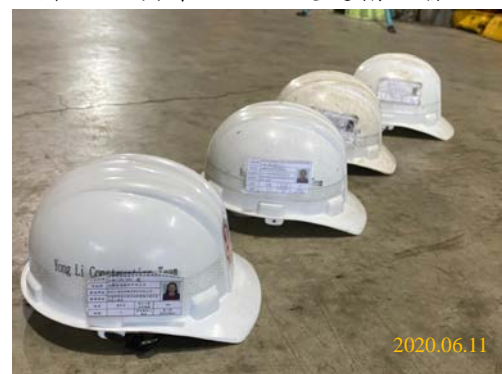
照片 3-2 安全帽標貼控管人員進出
