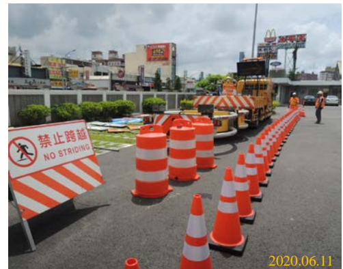
照片 2-2 演練工區之交通措施擺設
