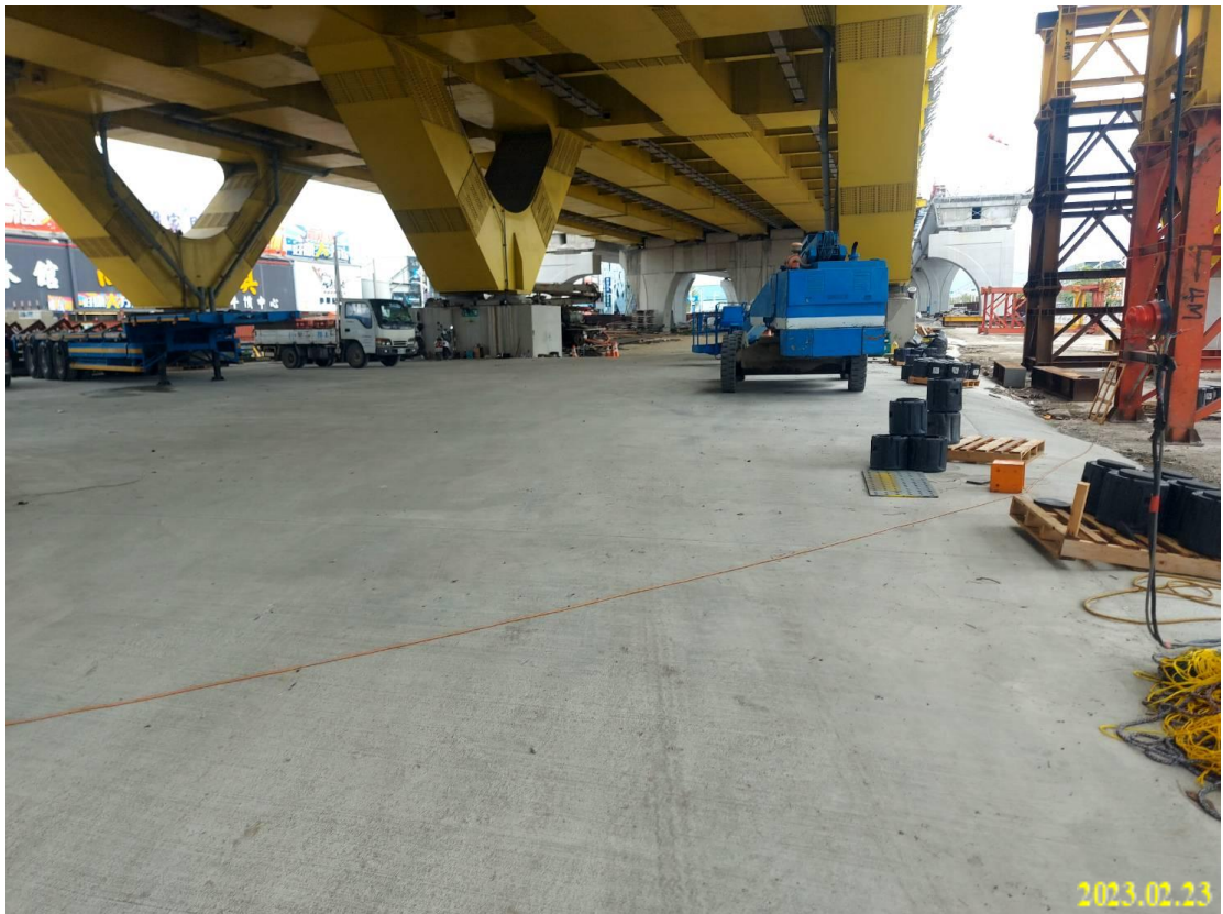
圖 5、常態性車行路徑鋪設 PC
