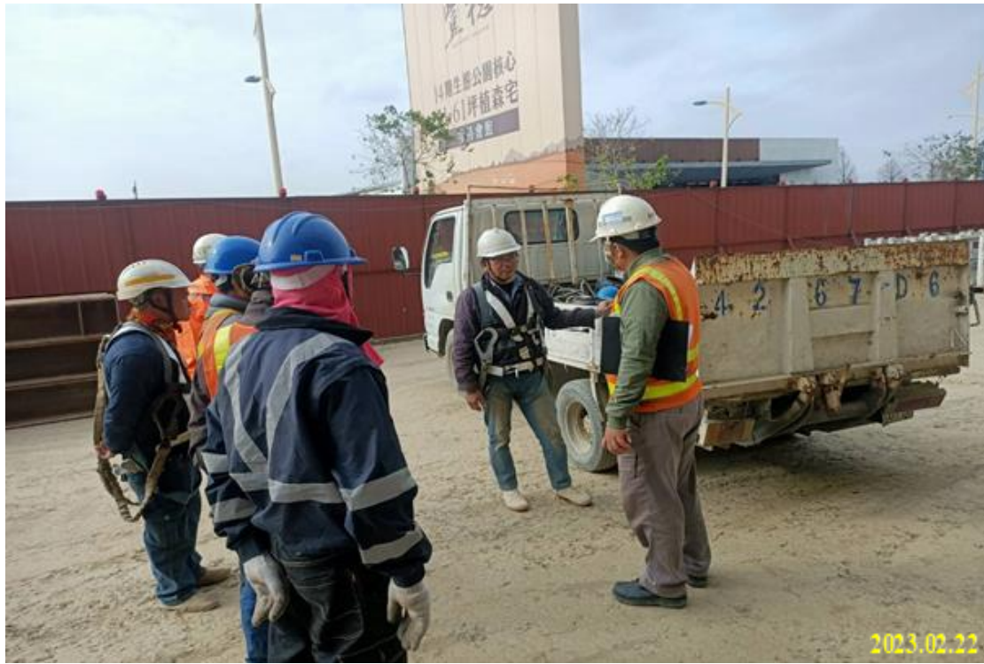
圖 7、施工人員安全事項宣導
