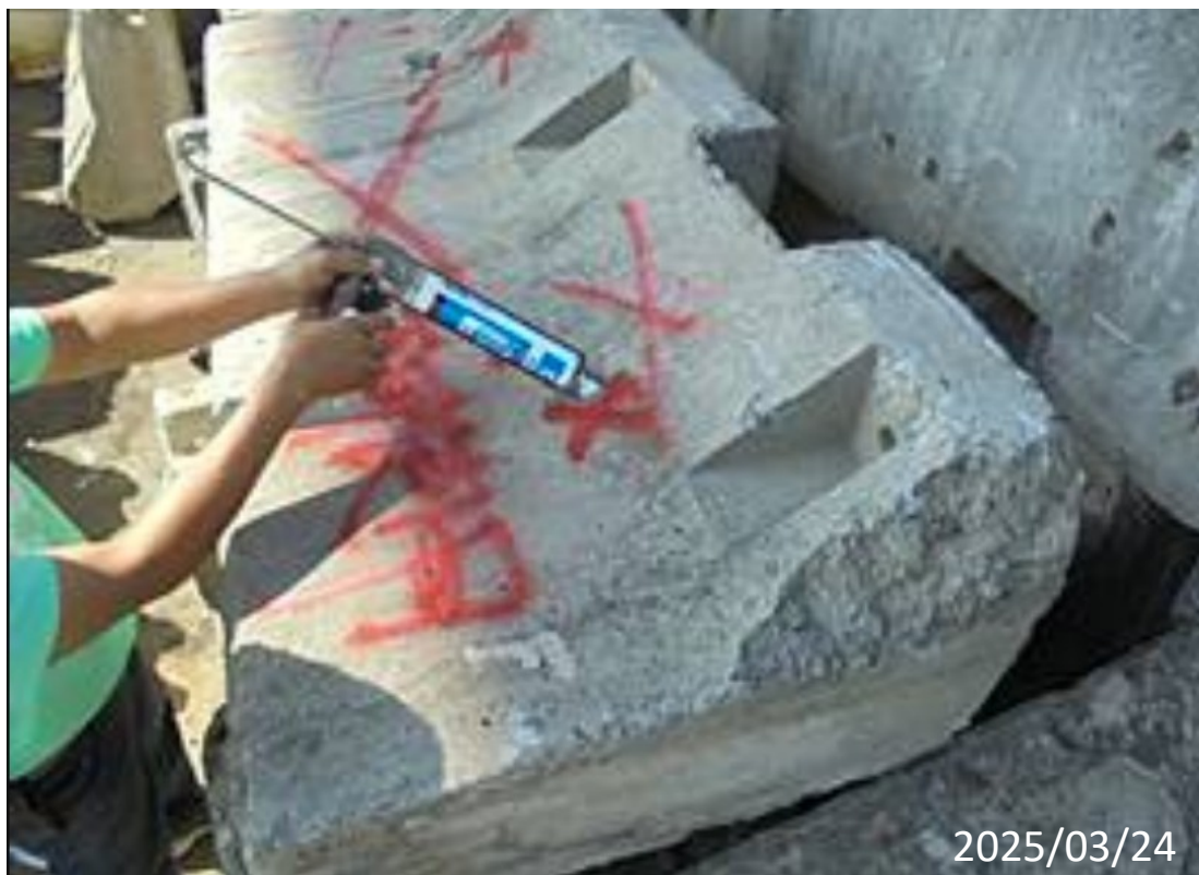
汰換使用性不佳之水泥護欄。
