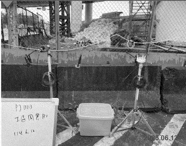
營建噪音 工區周界 114.06.12
