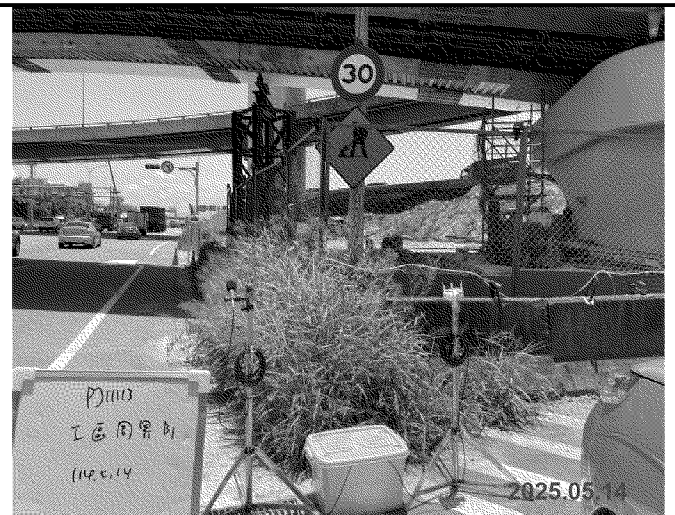
營建噪音 工區周界 114.05.14
