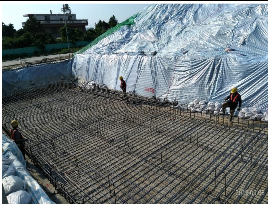
國道 4 號臺中環線豐原潭子段工程 108 年 9 月份施工照片
