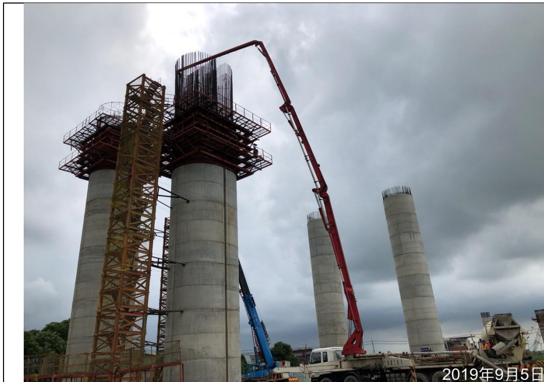
國道 4 號臺中環線豐原潭子段工程 108 年 9 月份施工照片
