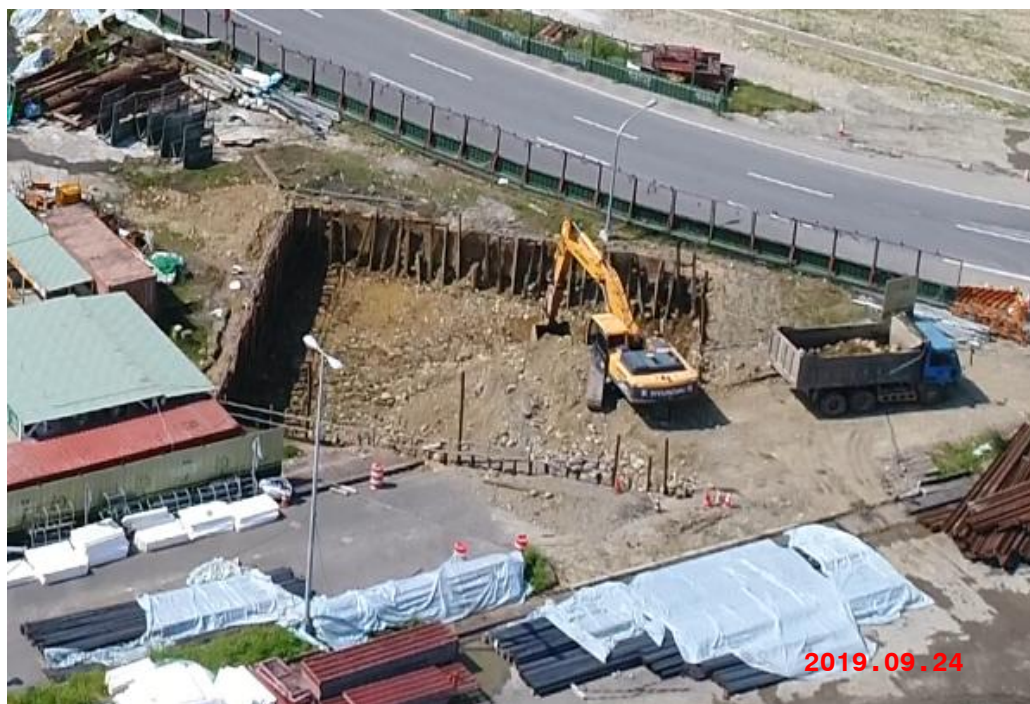
國道 4 號臺中環線豐原潭子段工程 108 年 9 月份施工照片
