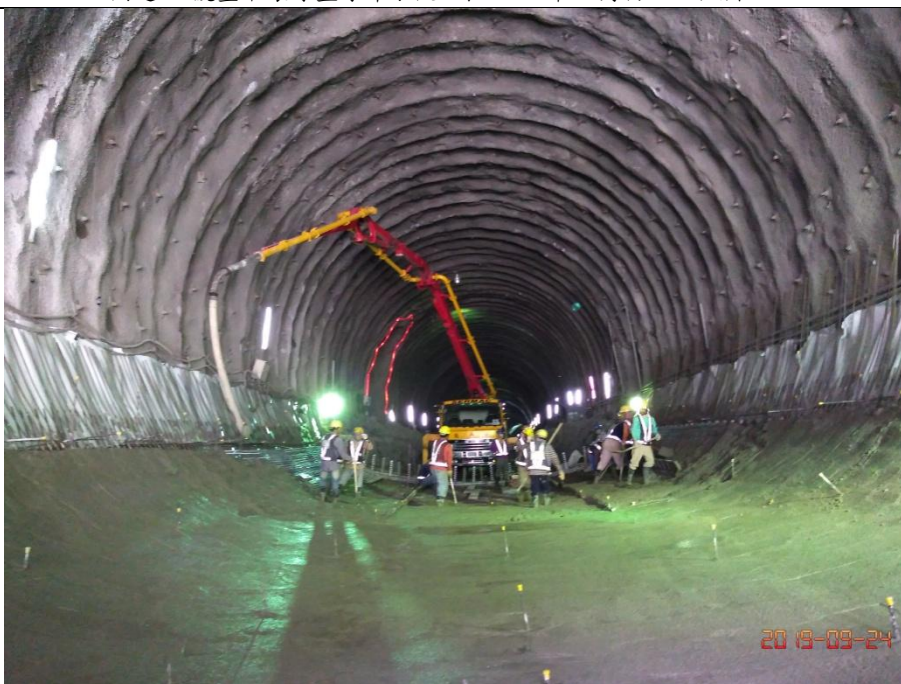
國道 4 號臺中環線豐原潭子段工程 108 年 9 月份施工照片
