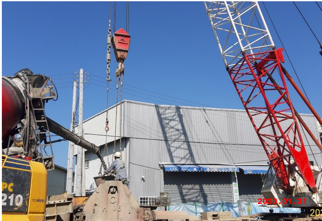
國道 4 號臺中環線豐原潭子段工程 109 年 01 月份施工照片
