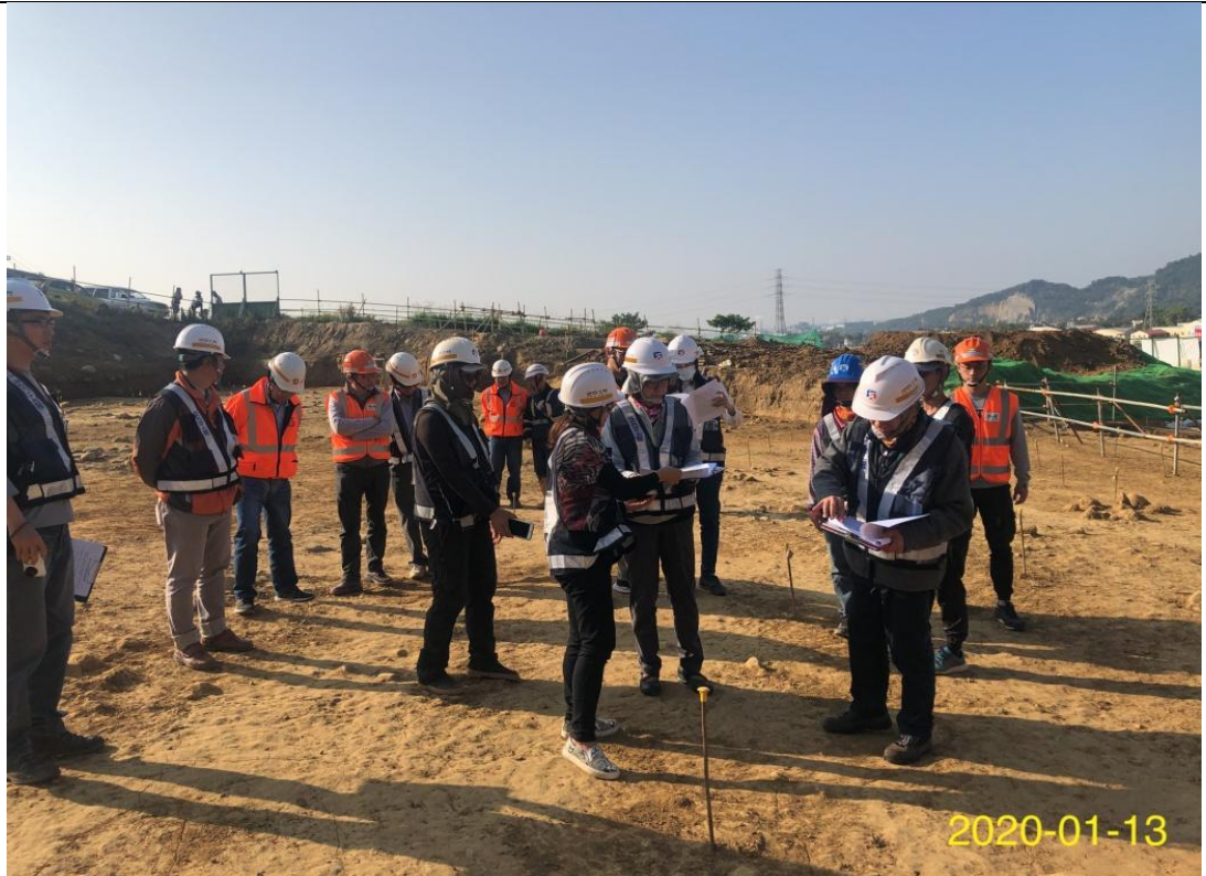
國道 4 號臺中環線豐原潭子段工程 109 年 01 月份施工照片
