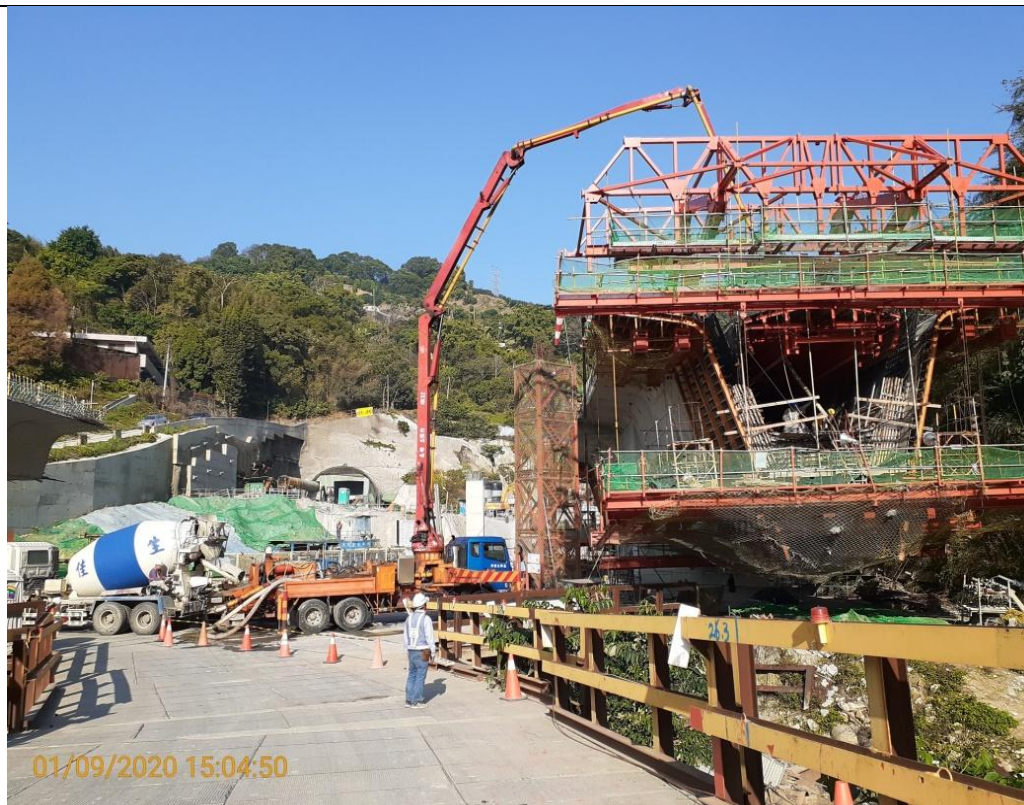
國道 4 號臺中環線豐原潭子段工程 109 年 01 月份施工照片
