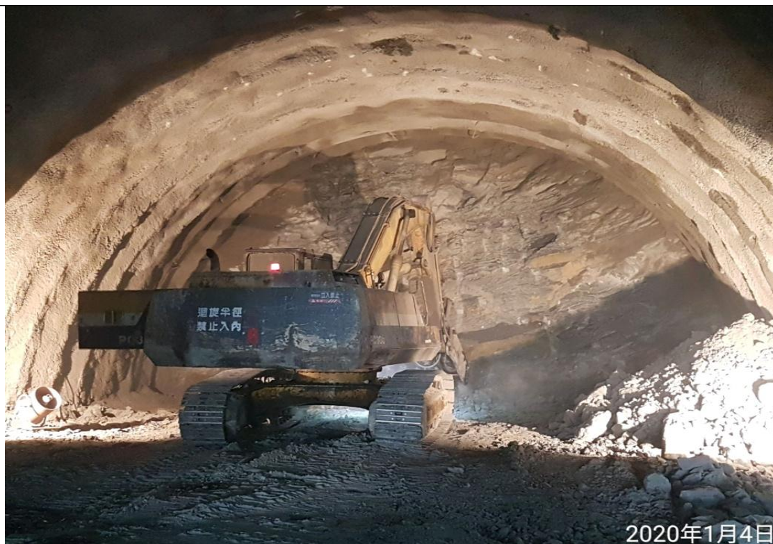
國道 4 號臺中環線豐原潭子段工程 109 年 01 月份施工照片
