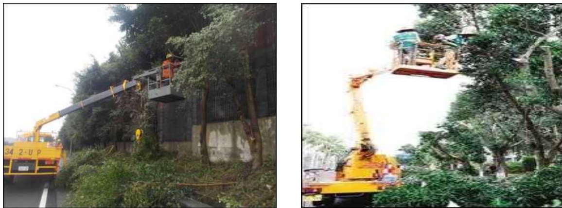
圖4、高空工作車等取代勞工站立於鋼筋混凝土護欄頂部作業
