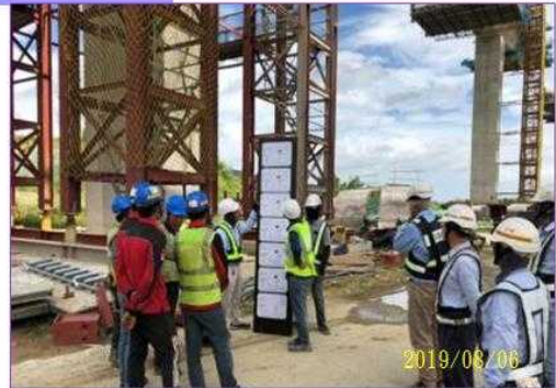
拆除工作車前進行安全衛生教育
