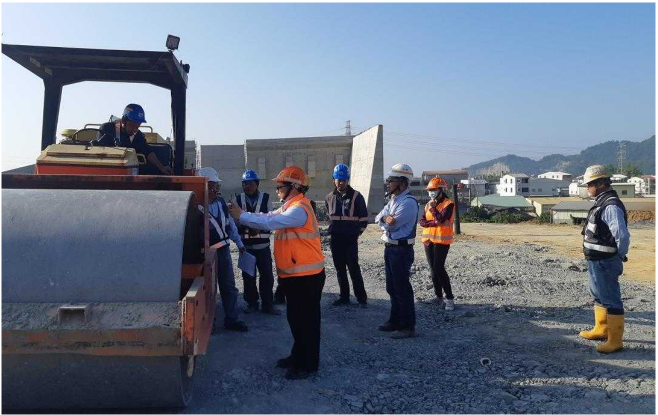
圖3、壓路機操作安全教育訓練
