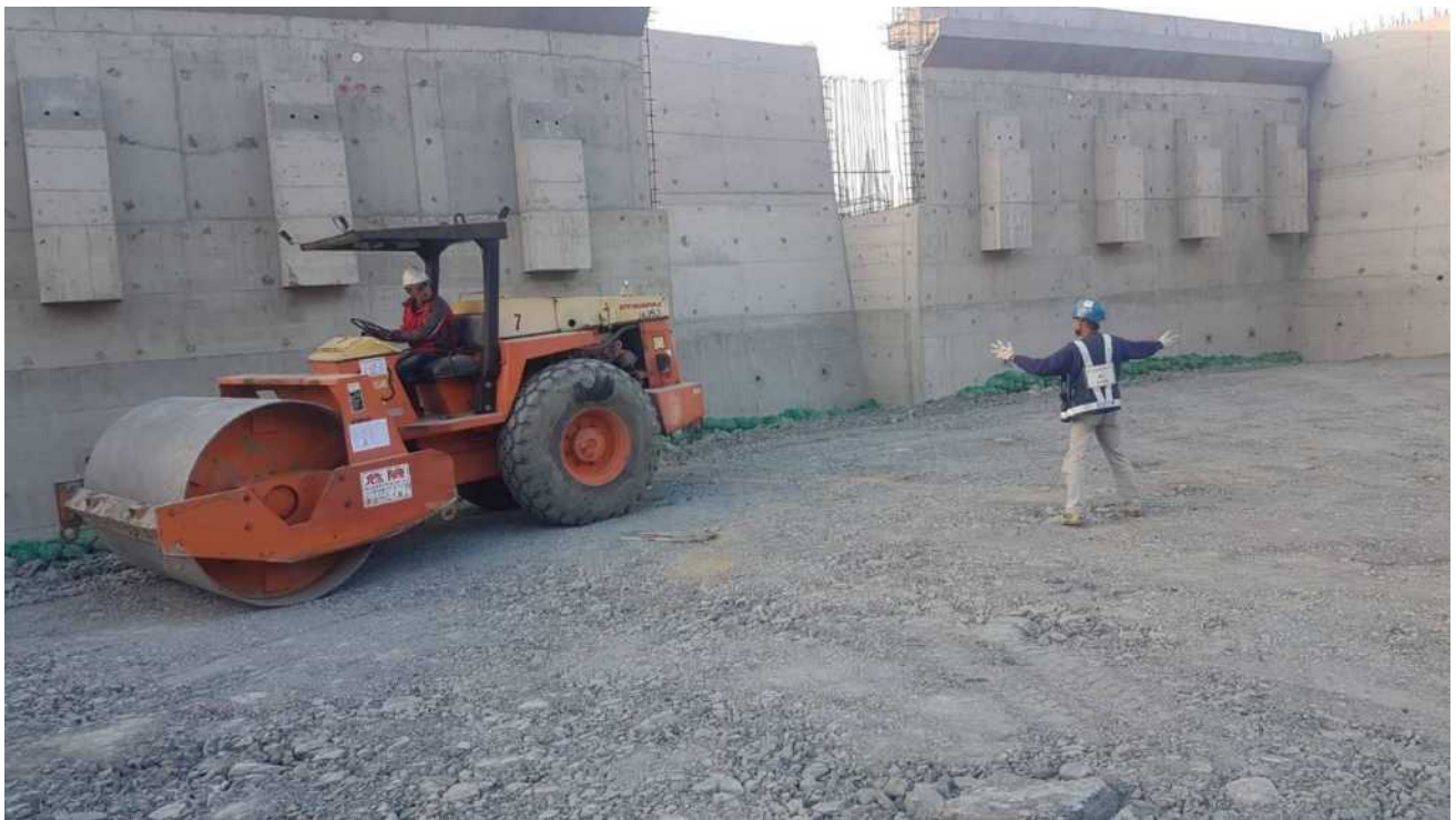
圖4、壓路機操作現場派監視、指揮人員配合作業
