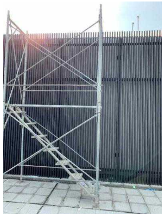
附件2、以施工架取代合梯作業，避免施工人員於高空作業時易於發生墜落、滾落危險
