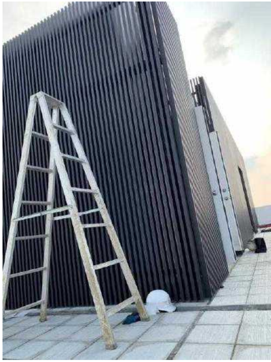
附件2、以施工架取代合梯作業，避免施工人員於高空作業時易於發生墜落、滾落危險
