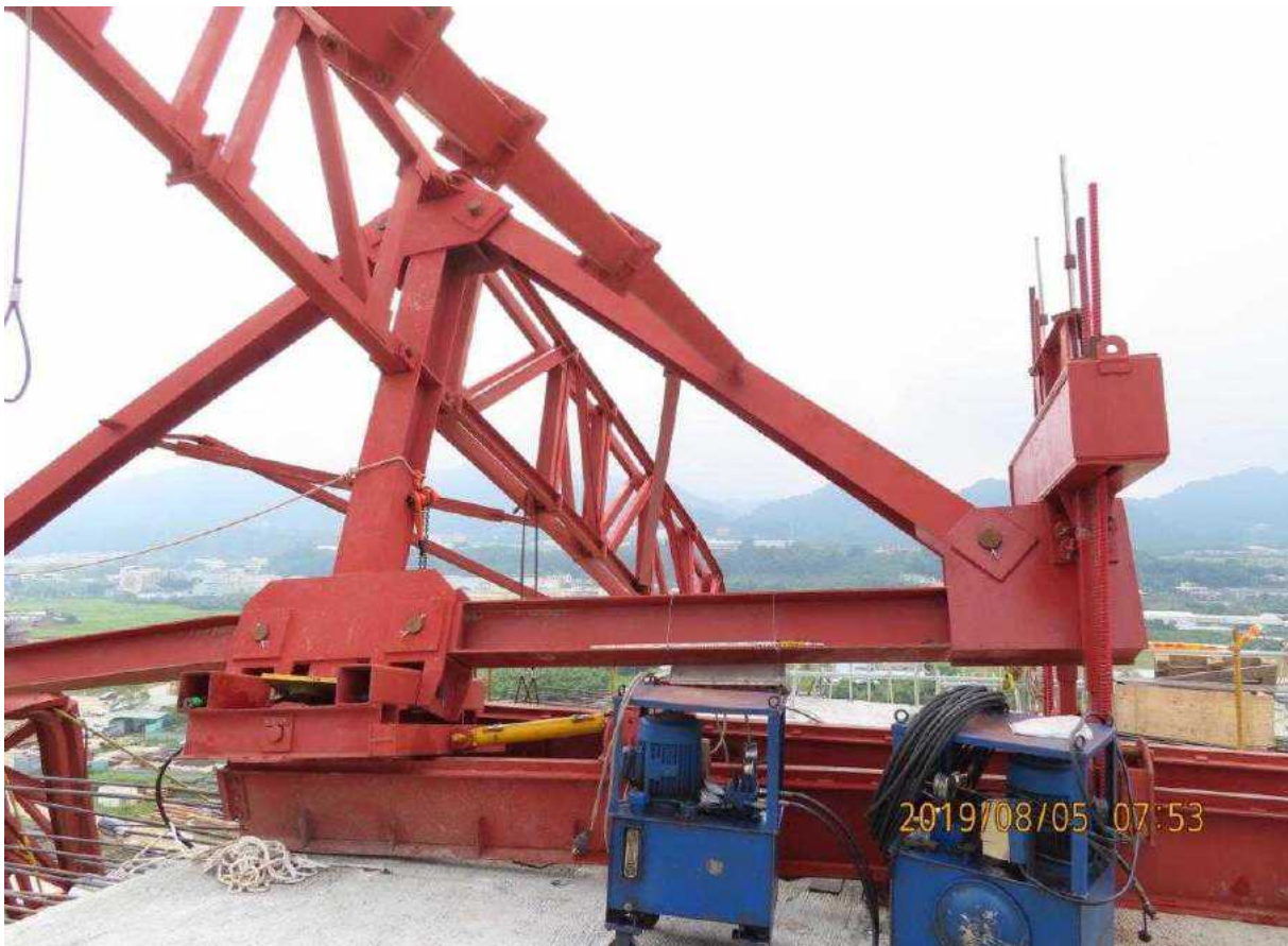
圖4、P22懸臂工作車前滾輪脫離導軌
