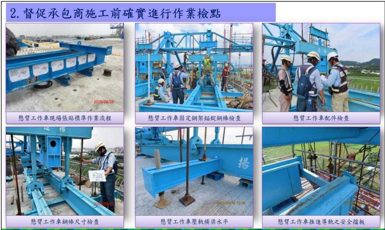
圖15、監造單位督促承包商施工前確實進行作業檢點
