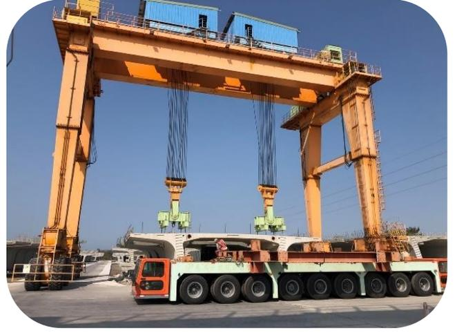
▲ 節塊儲存區吊運至多輪軸板車
