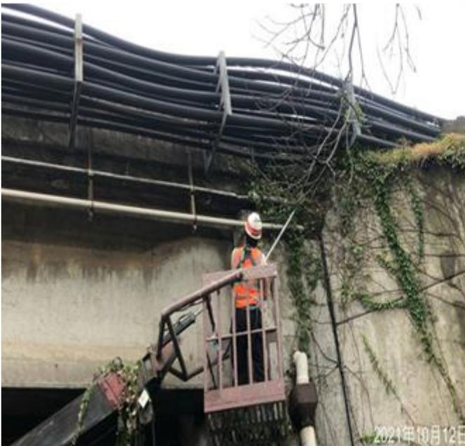
圖 1、使用高空車清理護坡
