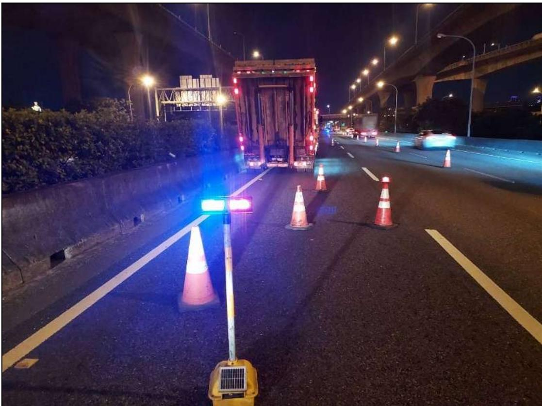
圖 4、停車車輛後方設置交通錐及爆閃燈
