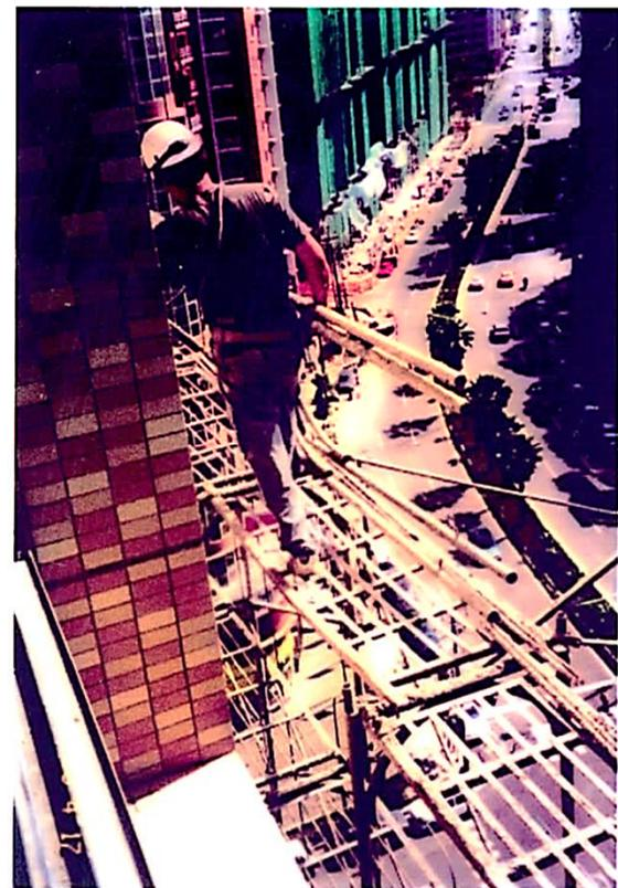
說明：拆架作業未設安全母索並確實使用安全帶。
