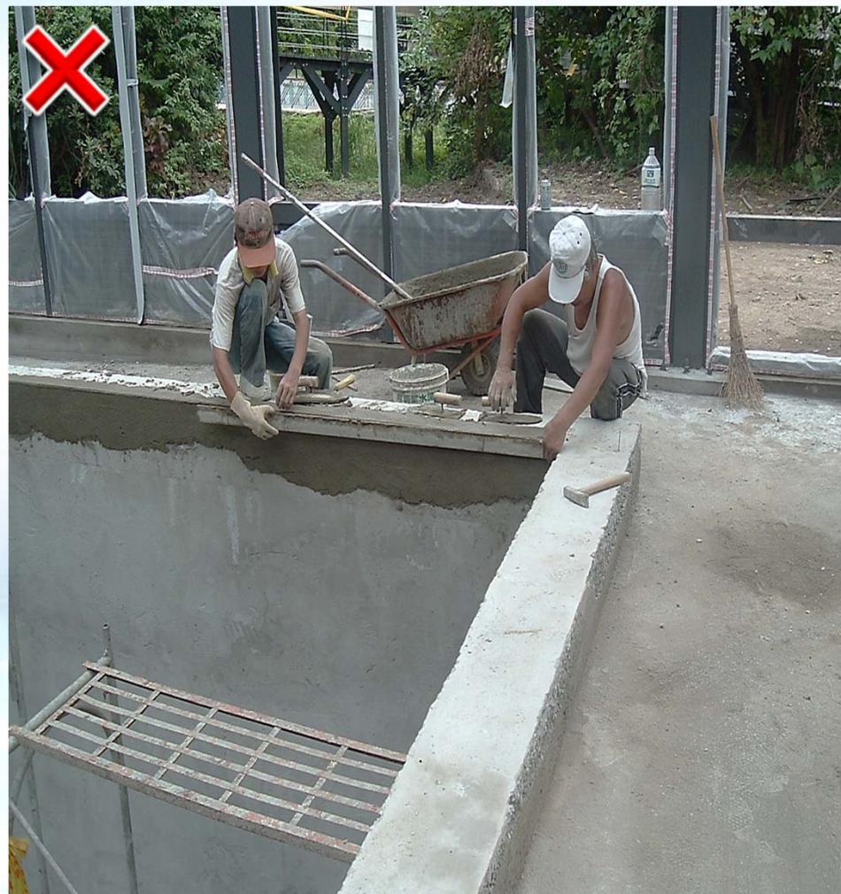
2公尺以上開口旁進行泥水粉刷作業，未設妥護欄，勞工未使用安全帶（開口上）、勞工未戴安全帽
