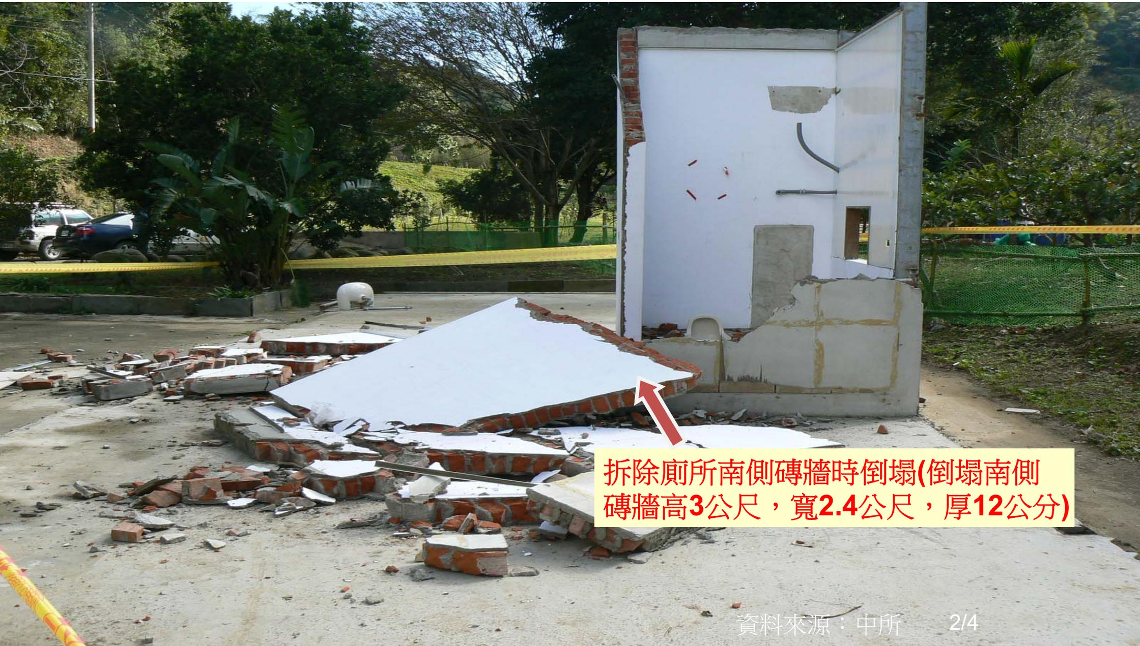
拆除廁所南側磚牆時倒塌(倒塌南側
