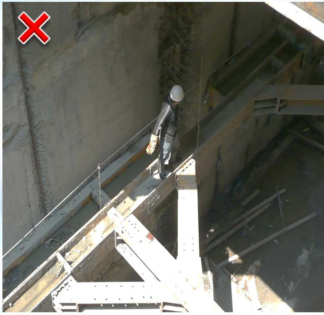
高處擋土支撐作業，2公尺以上擋土支撐未設安全網，
