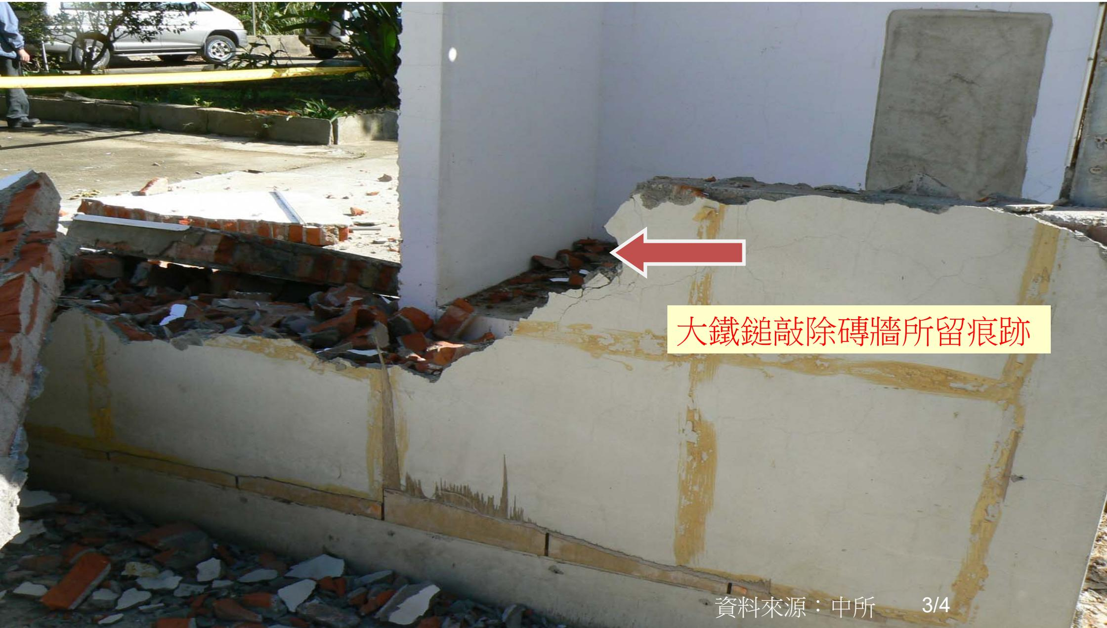
大鐵鎚敲除磚牆所留痕跡
