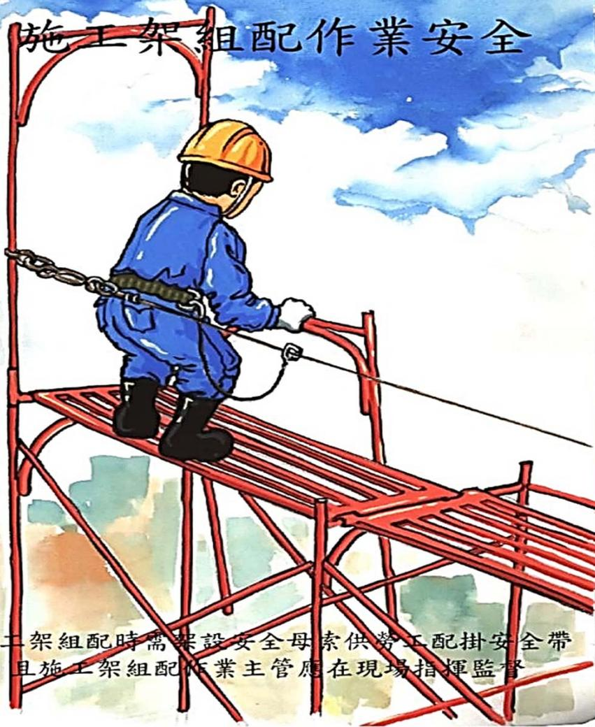
施工架組配時需架設安全母索供勞工配掛安全帶
