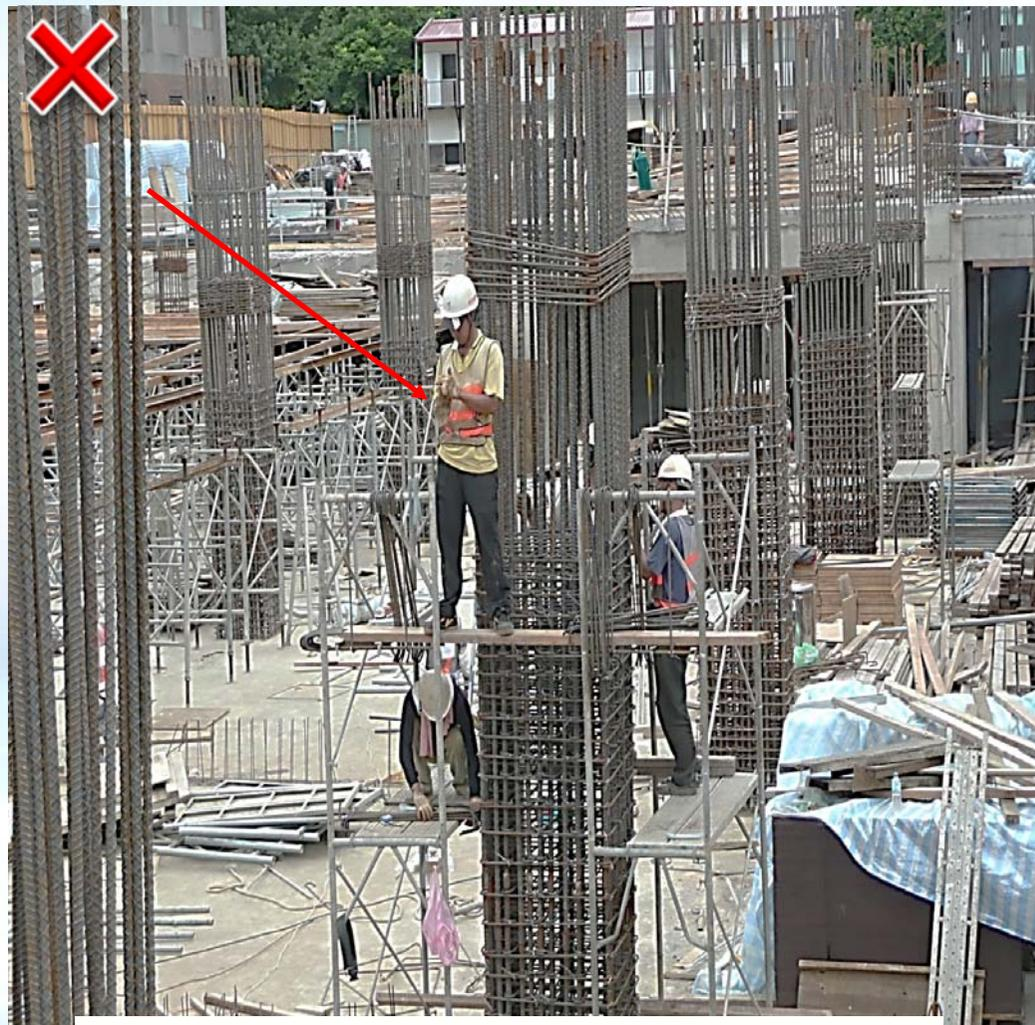
2公尺以上高處鋼筋綁紮未設妥工作臺，勞工未使用安全帶站立在角材上
