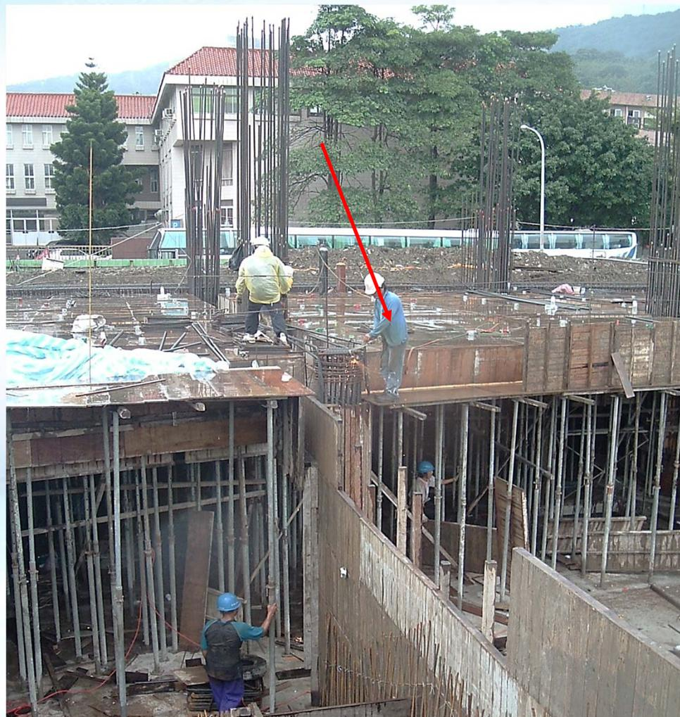
2公尺以上高處鋼筋綁紮，開口未設護欄，勞工未使用安全帶站立在樑底模上
