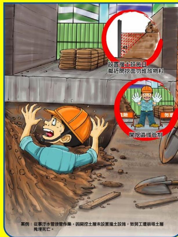
案例：從事污水管接管作業，因開挖土層未設置擋土設施，致勞工遭崩塌土層掩埋死亡。
