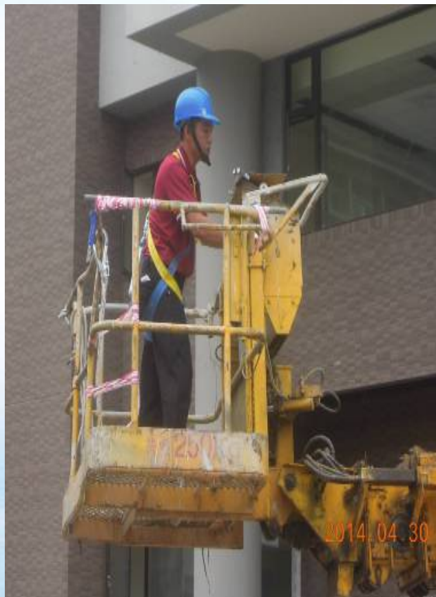
高空作業車操作人員配勾掛安全帶
