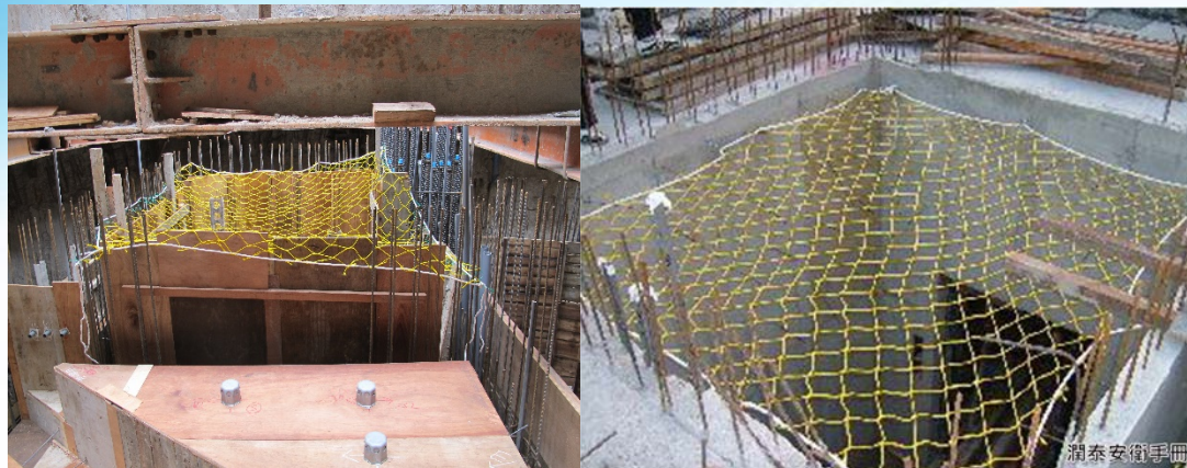
電梯井組模時之防護措施/拆模階段之防護措施
