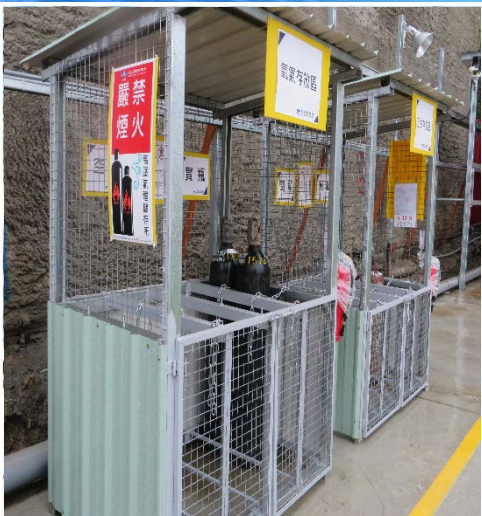
◎氧氣乙炔鋼瓶儲存區 / 搬運架(推車)+滅火器+簡易遮陽板
