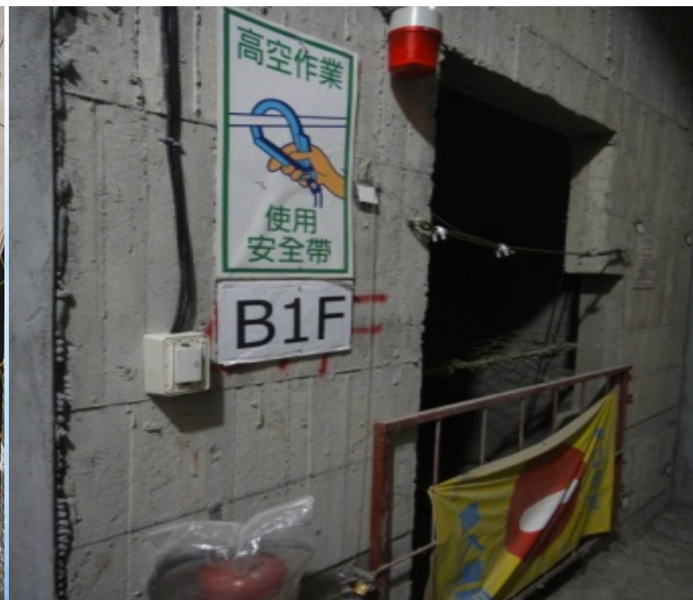
電梯井組模時之防護措施/拆模階段之防護措施
