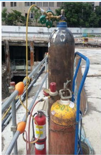
◎氧氣乙炔鋼瓶儲存區 / 搬運架(推車)+滅火器+簡易遮陽板
