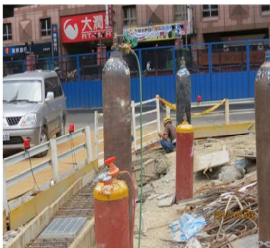
◎鋼瓶直立或倒置使用未固定且未裝防回火裝置 / 鋼瓶變形。
