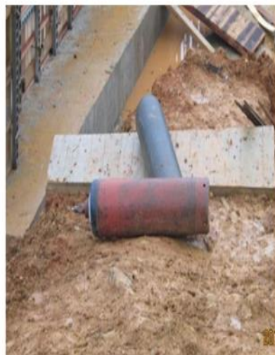
◎氧氣乙炔鋼瓶未分隔貯存 / 壓力計破損+皮管老化龜裂 / 鋼瓶任意棄置。
