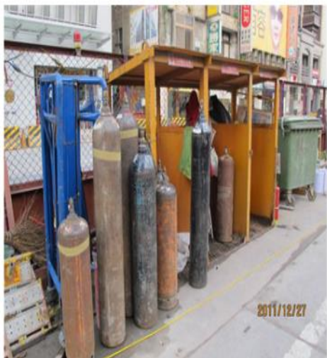
◎氧氣乙炔鋼瓶未分隔貯存 / 壓力計破損+皮管老化龜裂 / 鋼瓶任意棄置。
