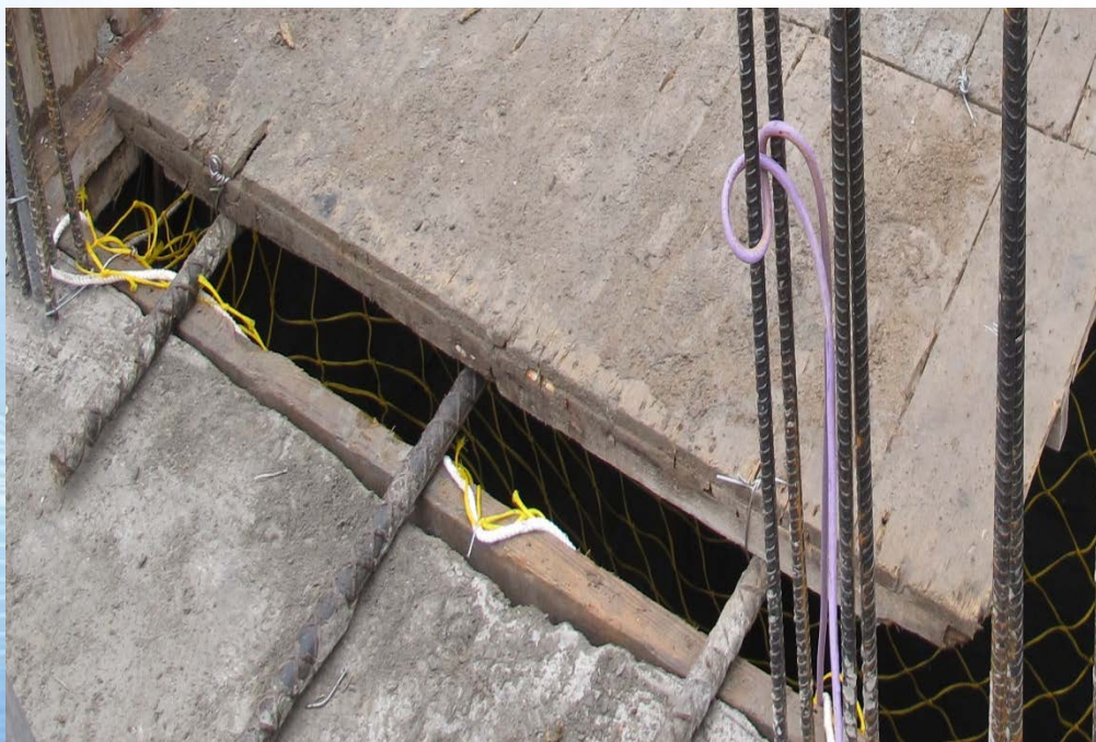
工作平台搭設/電梯開口防護完成圖
