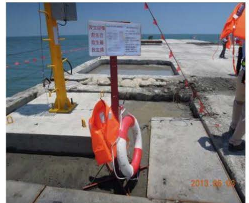
設置防止勞工落水之設施或使勞工穿著救生衣，於工作場所或附近，設置足夠數量之救生設備。
