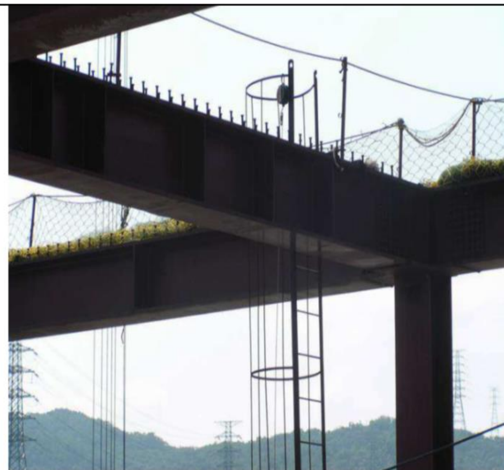
◎ 護籠梯加裝防墜器 供人員安全上下鋼樑
