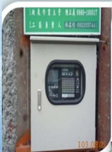
固定式氣體偵測器全時監測
