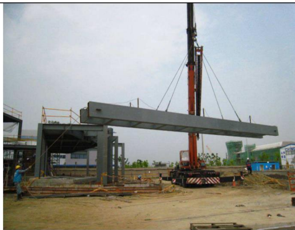
◎吊運長型構架採 雙點雙索 （四索）吊掛，以保持平穩。
