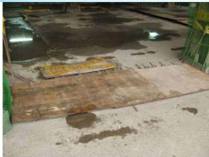
◎預留筋套筒 / 通道鋼筋彎折加板保護
