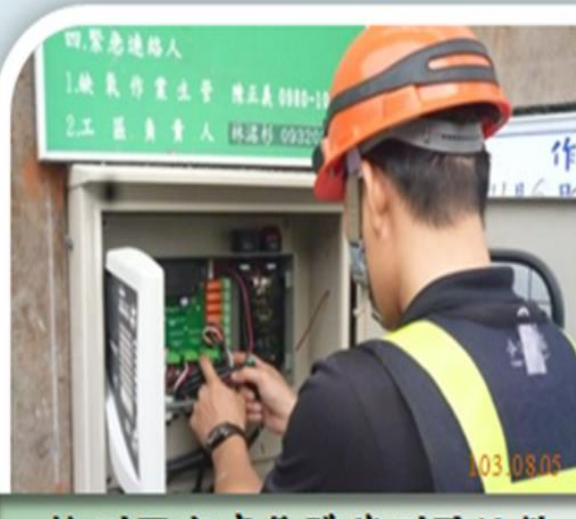
檢測固定式氣體偵測器設備
