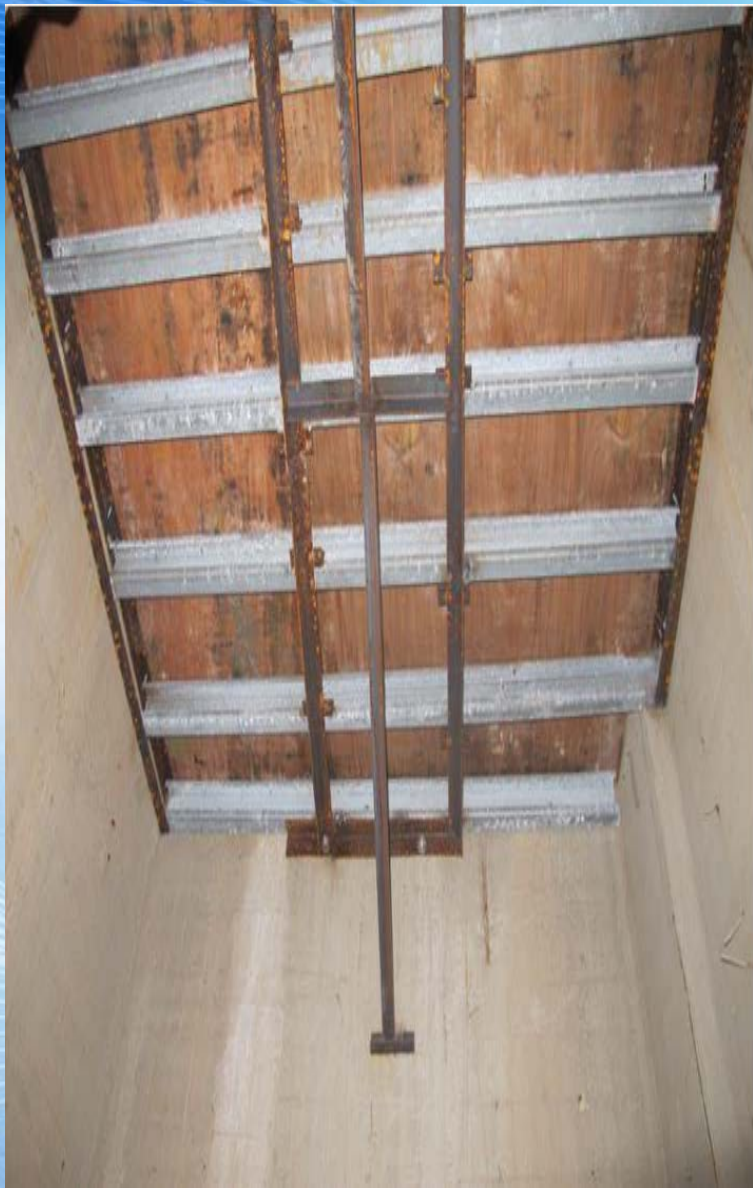
吊料平台承載底部施作方式
