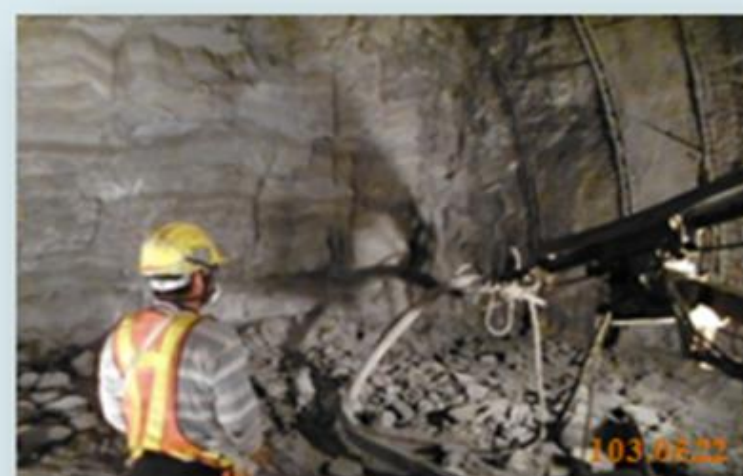
護目鏡、防塵呼吸罩防護 遙控式噴漿機
