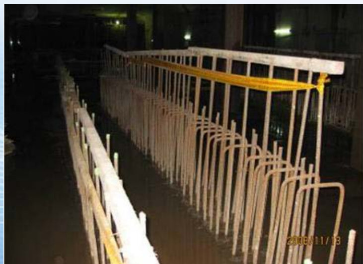
◎以角材保護/彎曲防止鋼筋穿刺作法
