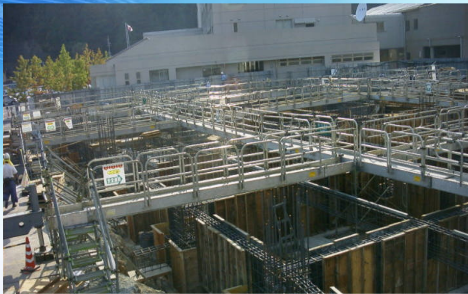
地樑施工時 設置安全上下設備及通道
