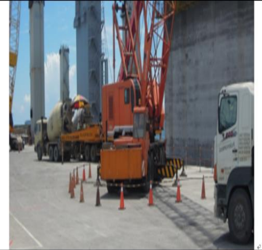
◎吊掛作業半徑內禁止人員進入。
