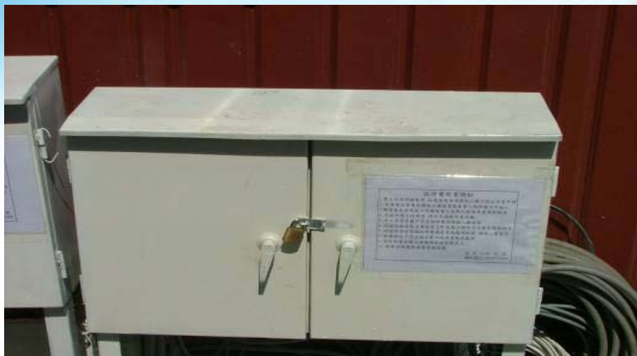
◎配(分)電盤應以箱、蓋等予以護圍，防止人員觸及，張貼保管人資訊並上鎖管制。
