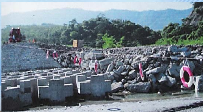
設置防止勞工落水之設施或使勞工穿著救生衣，於工作場所或附近，設置足夠數量之救生設備。
