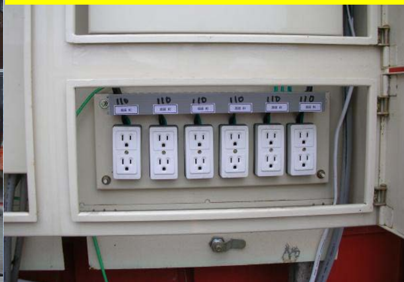
◎配(分)電盤、箱設置插座專用箱、標示使用電壓、使用接地型插座，且不妨礙箱門之關閉。
