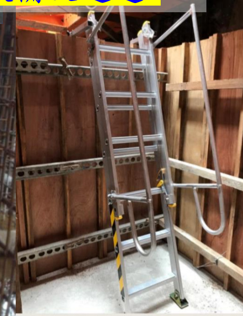
地樑施工時 設置安全上下設備及通道
