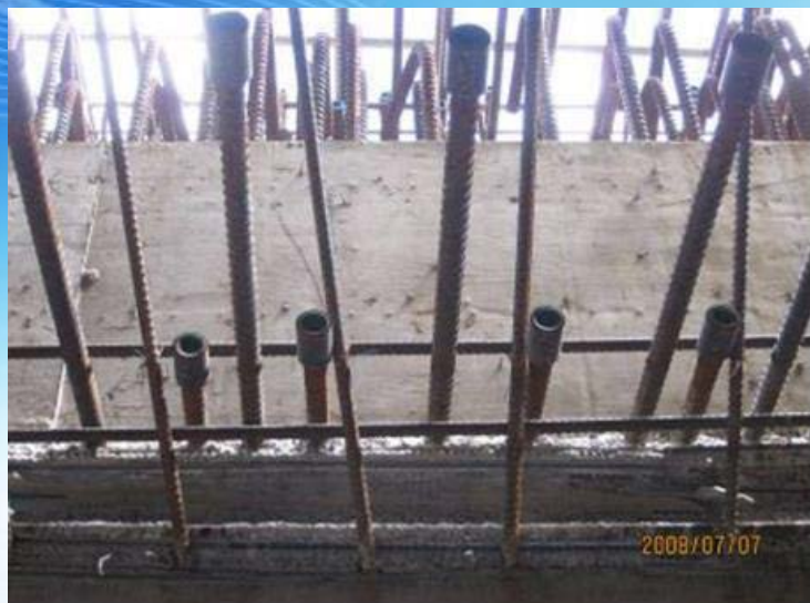
◎預留筋套筒 / 通道鋼筋彎折加板保護
