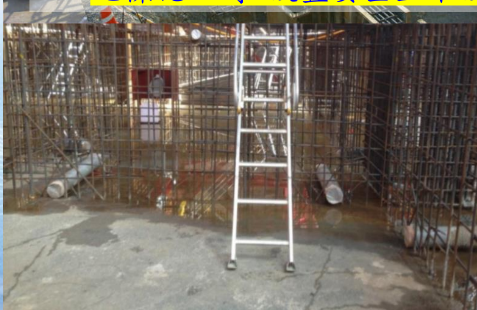
地樑施工時 設置安全上下設備及通道
