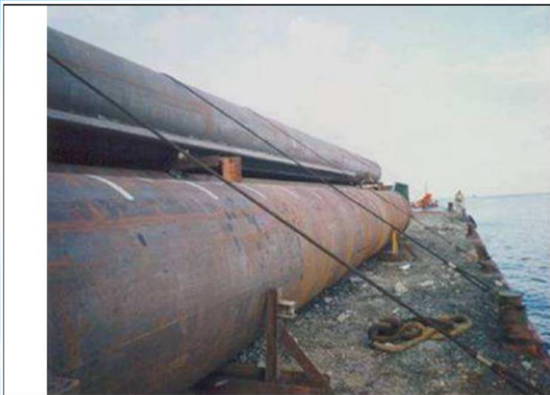
◎採取繩索捆綁、 擋樁 等措施，防止物料倒塌、崩塌或掉落。
