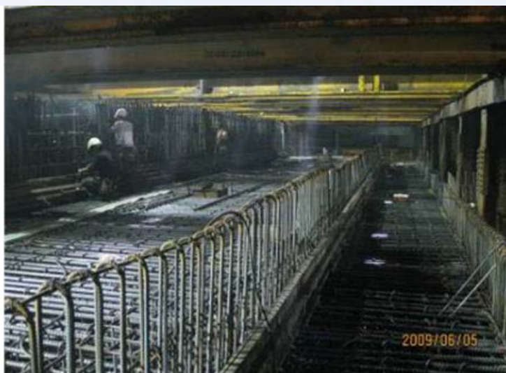
◎以角材保護/彎曲防止鋼筋穿刺作法
