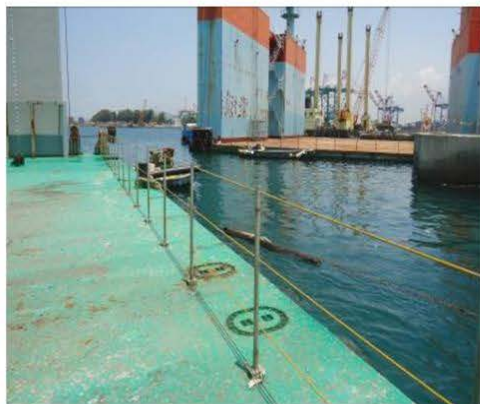
設置防止勞工落水之設施或使勞工穿著救生衣，於工作場所或附近，設置足夠數量之救生設備。
