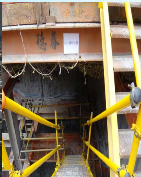
地樑施工時 設置安全上下設備及通道
