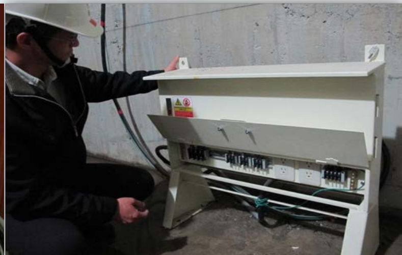
◎配(分)電盤、箱設置插座專用箱、標示使用電壓、使用接地型插座，且不妨礙箱門之關閉。
