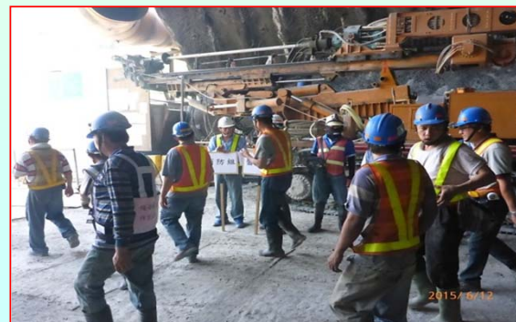
指引隧道內人員疏散演練
