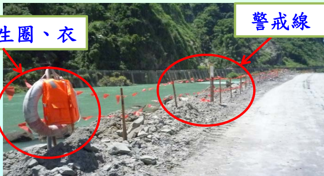
施工便道臨水側設置警戒線及救生裝備
