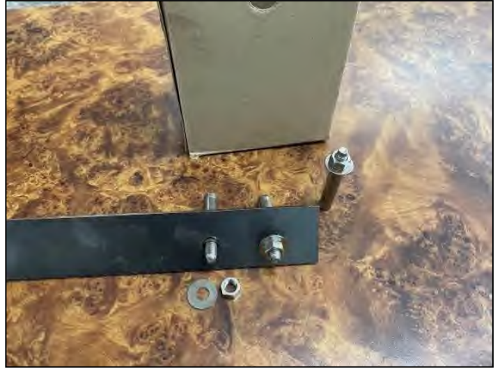
圖 7、維修人孔蓋十字壓條加固及膨脹螺栓錨定
