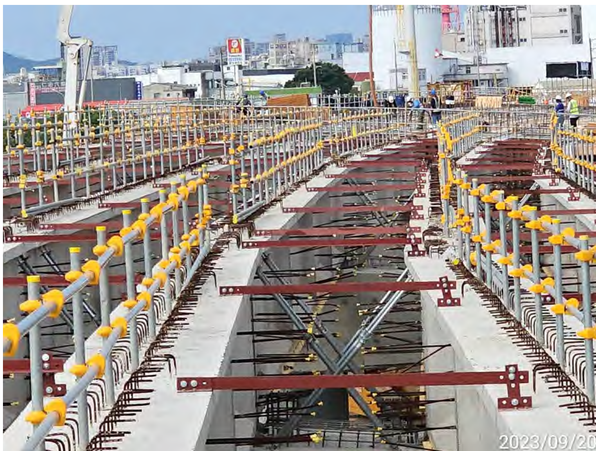
▲ 預力 I 型梁頂部橫向連結及安全防護
