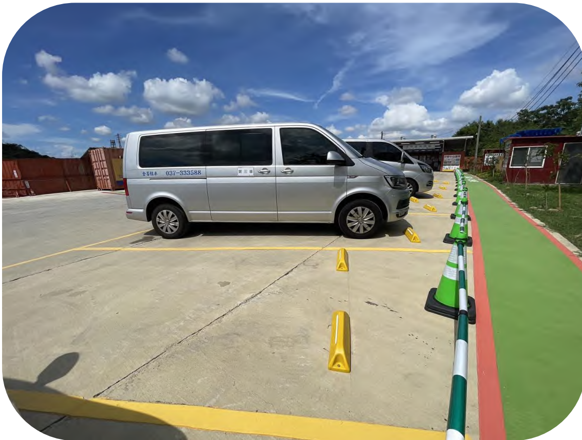
▲ 工地停車場設車輪擋及人車分道
