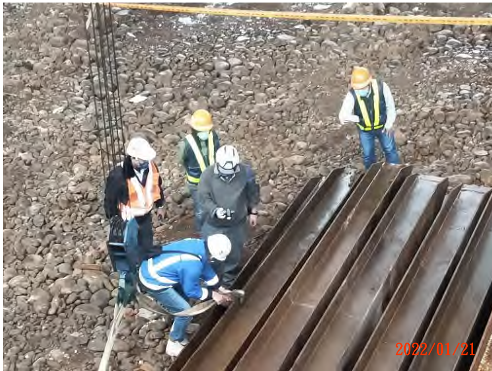
圖 6、職安中心現場勘查
