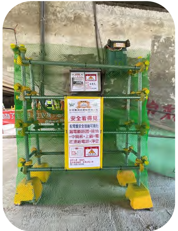
▲ 用電設備絕緣防護網
