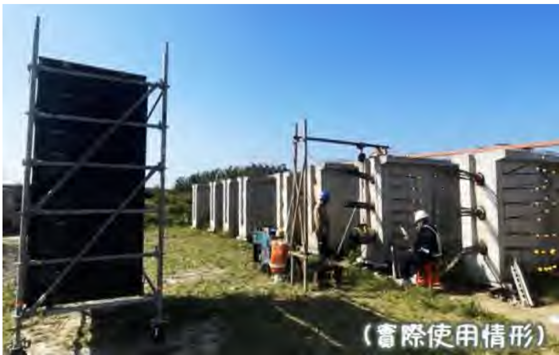
▲ 包覆式施工架(緩衝鋼鍵飛射力道)
