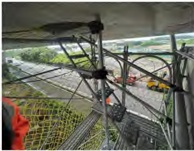
說明：墩柱上下設備架設防護網，並拉伸至箱型梁內。
