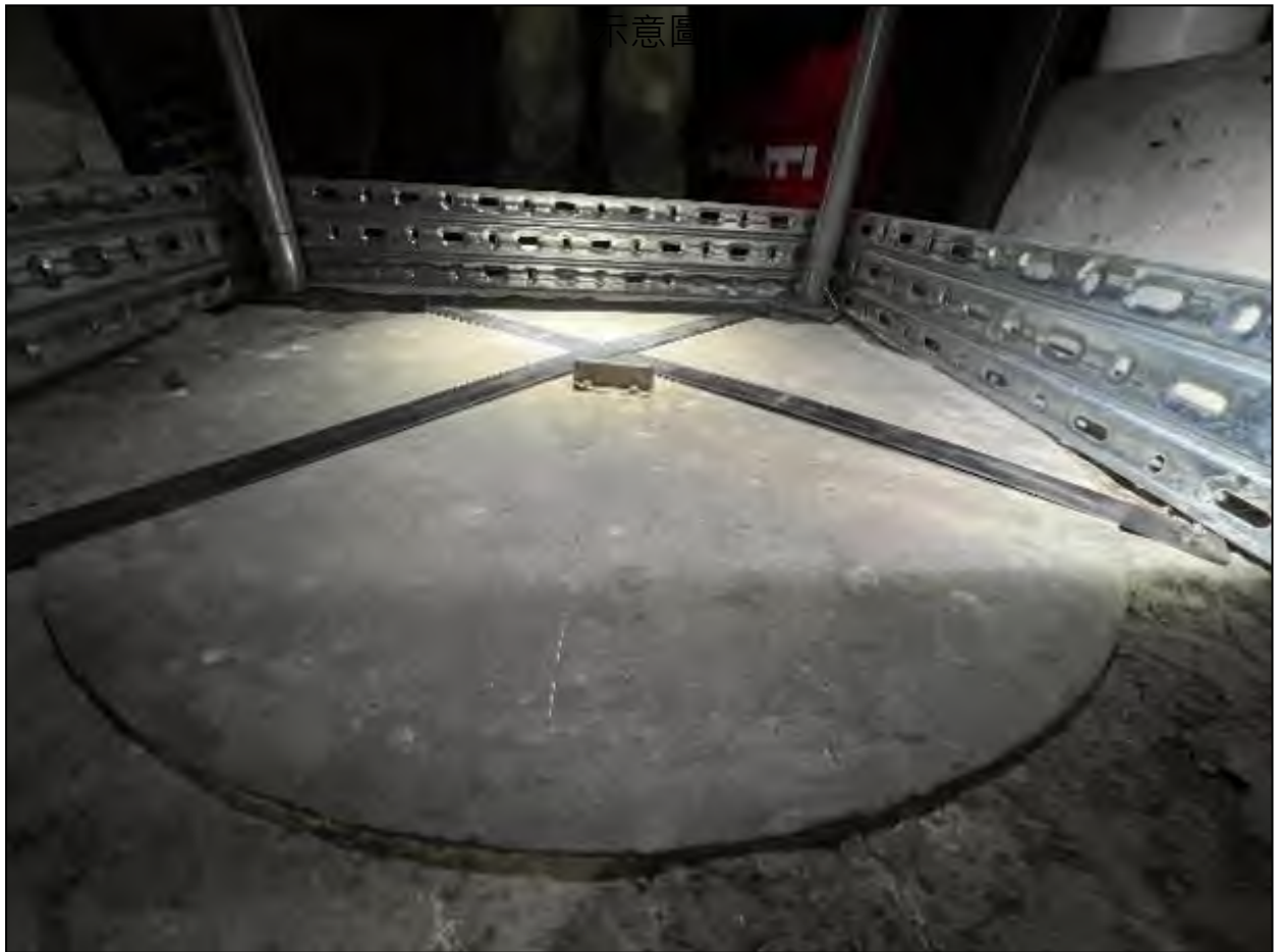
圖 8、維修人孔蓋十字壓條加固及膨脹螺栓錨定情形
