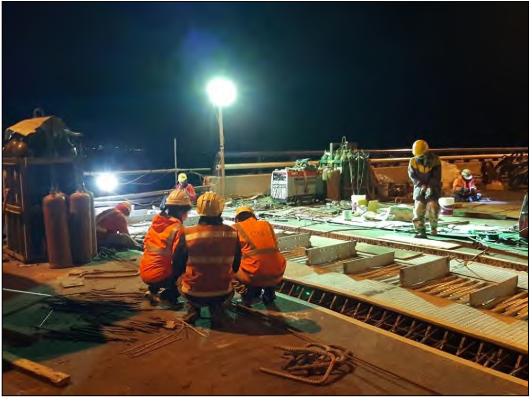
圖 5、伸縮縫施工加強輔助照明
