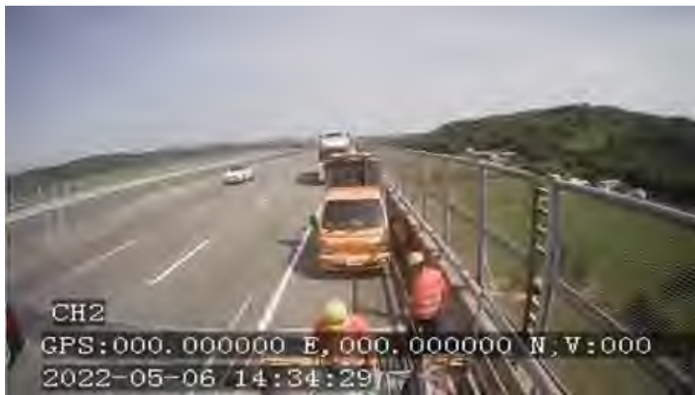
圖 4、施工人員均位於工作車下游、用人偏離原行駛車道
