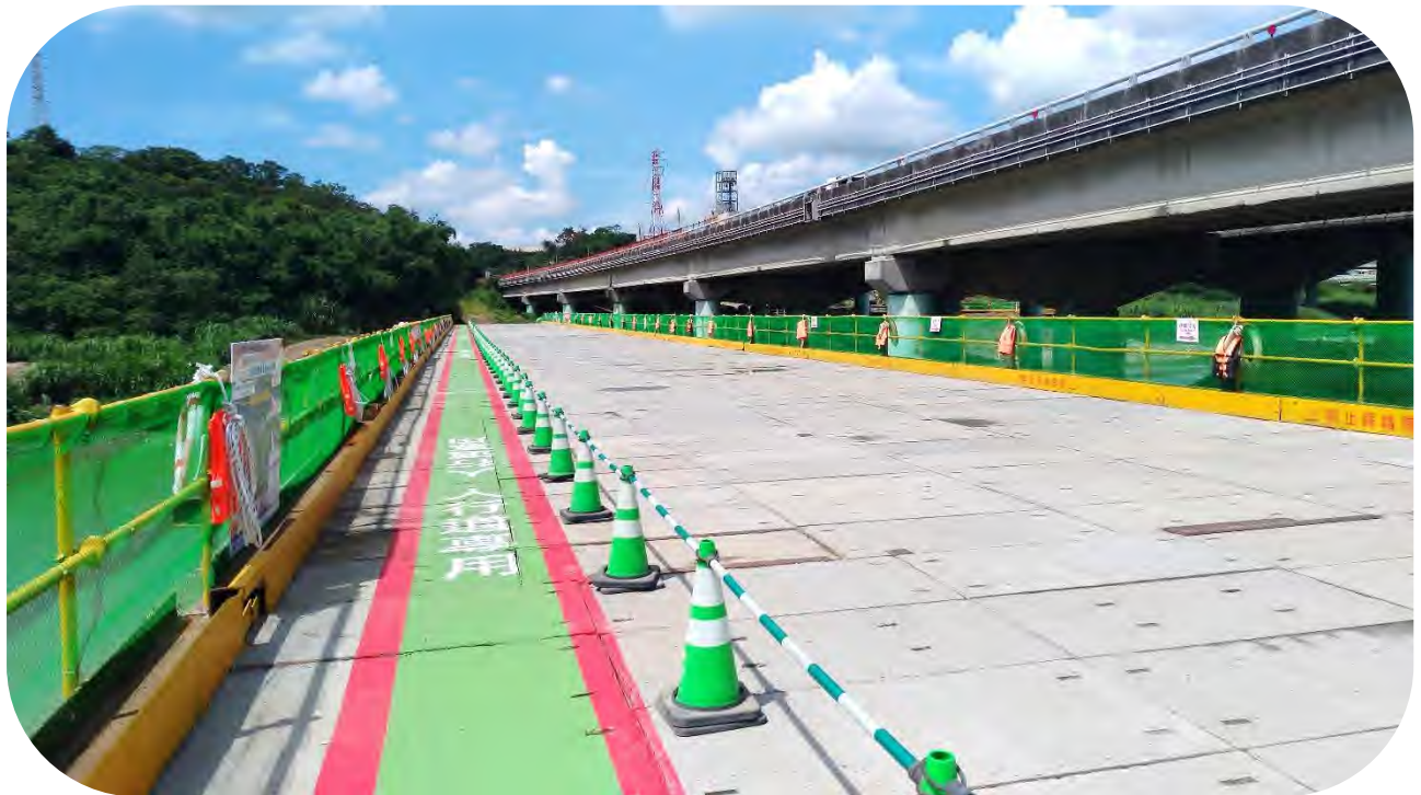
▲ 施工棧橋人車分道
