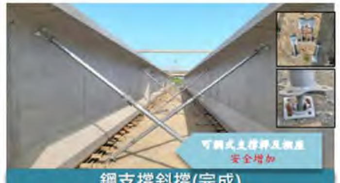
臨時鋼斜撐(下方可調楔座固定)
