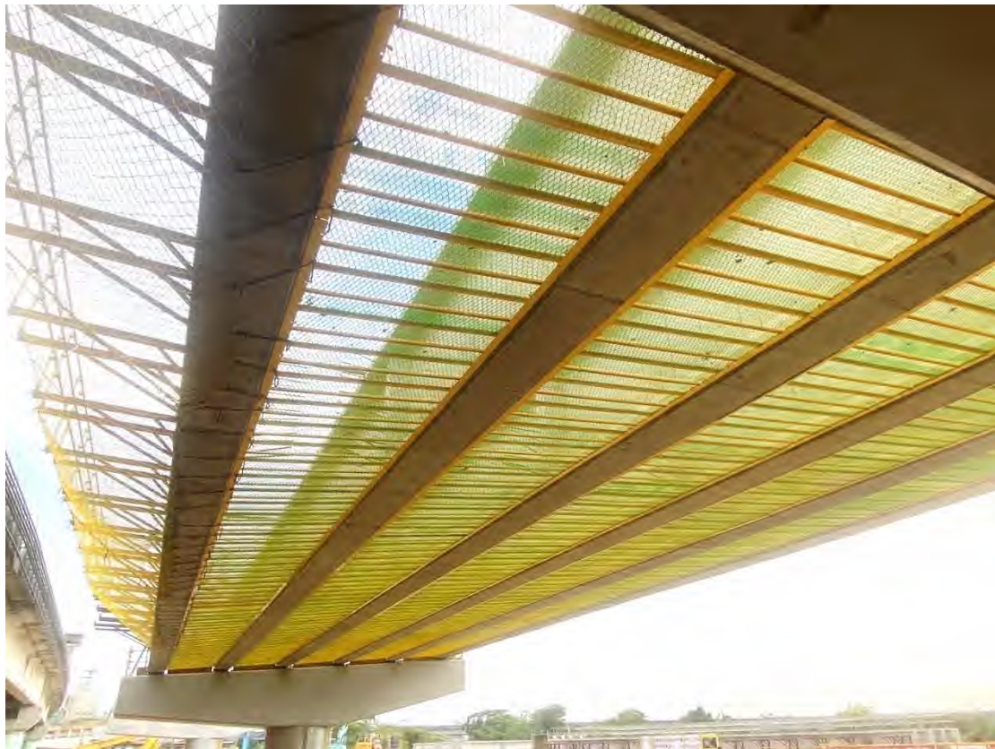
▲ 預力 I 型梁吊裝後施工平台
