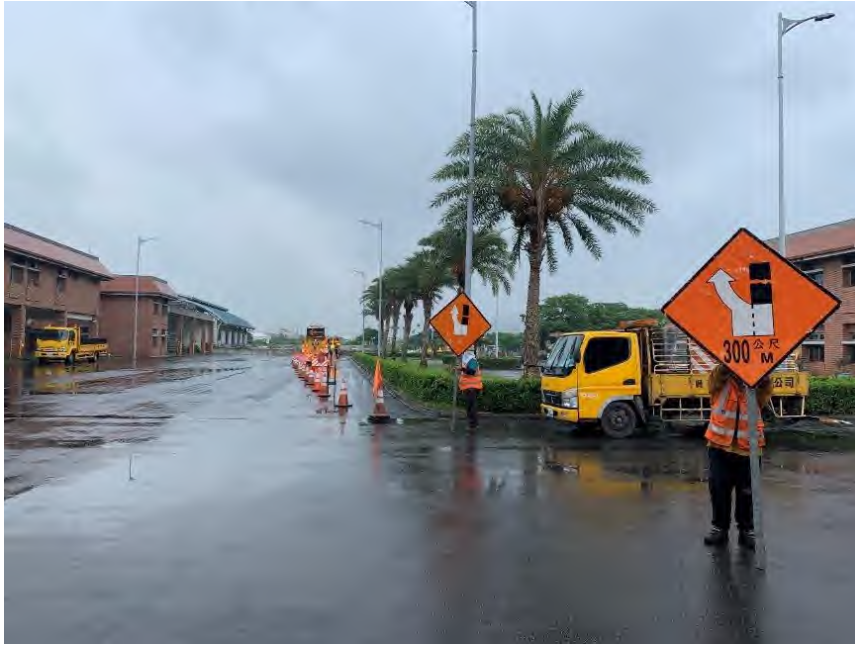
圖12、交通管制措施實地演練
