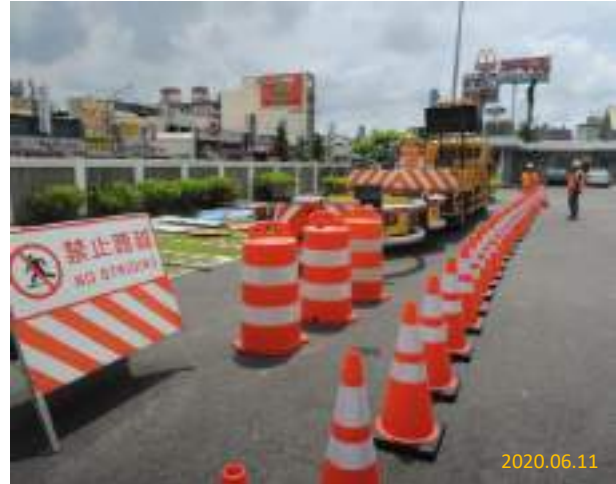
圖 8、演練工區之交通設施擺設
