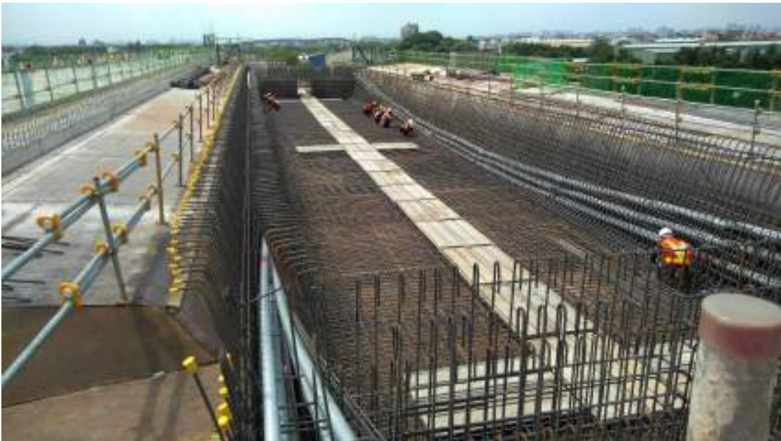
圖 6、橋梁上構 (箱梁) 施工
