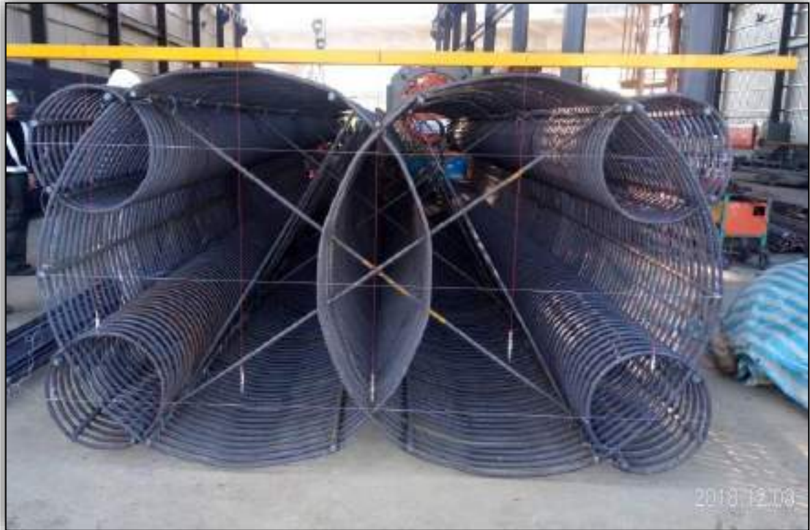
圖 2、多螺箍橋墩鋼筋
