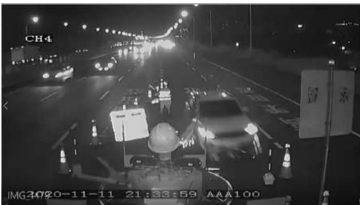
圖 3、工區後方影像紀錄 2 (呈左右相反)
