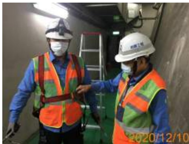
作業人員應將安全帶吊掛於堅固處所
