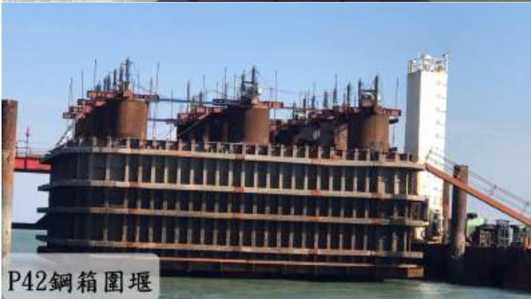
圖 4、金門大橋鋼箱圍堰施工
