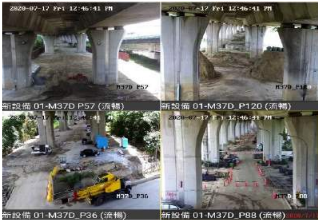
圖 6、高風險區域設置監視系統
