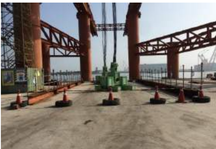
圖 4、作業後吊具置地，作業區域 採型鋼圈圍及安全欄杆
