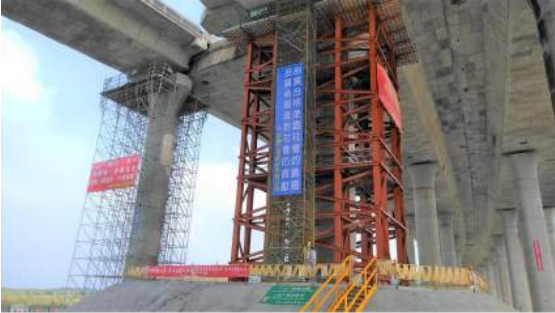
圖 5、M37F 耐震補強工程
