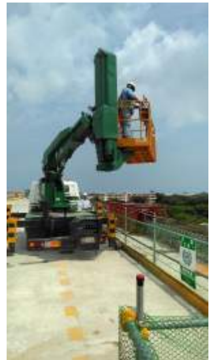
圖 8、橋梁永久護欄機械施工
