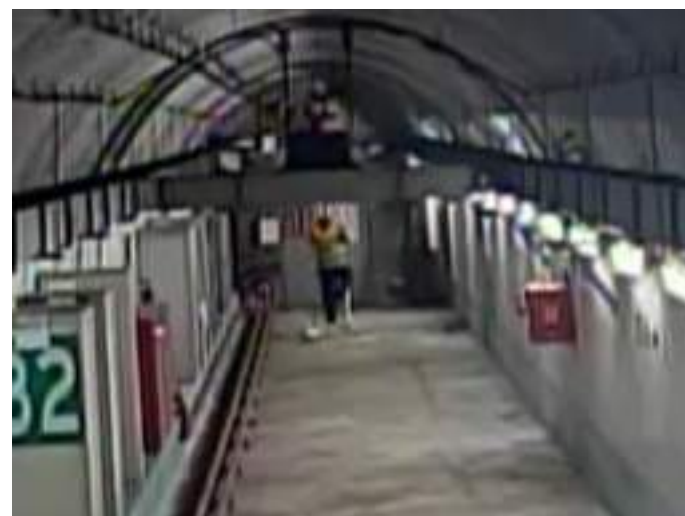
圖 5、作業場所(人行聯絡隧道)
