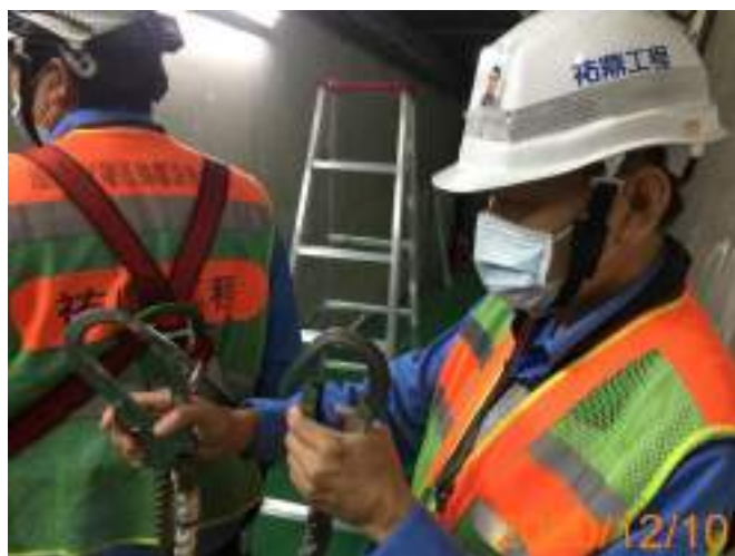
作業人員應將安全帶吊掛於堅固處所
