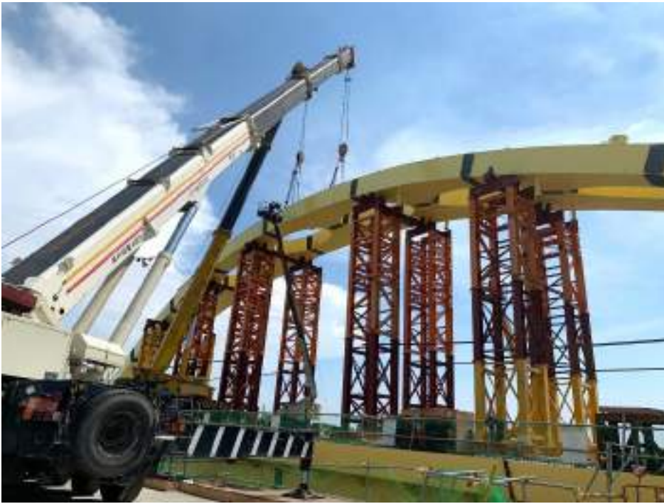
圖 7、鋼拱橋吊裝施工
