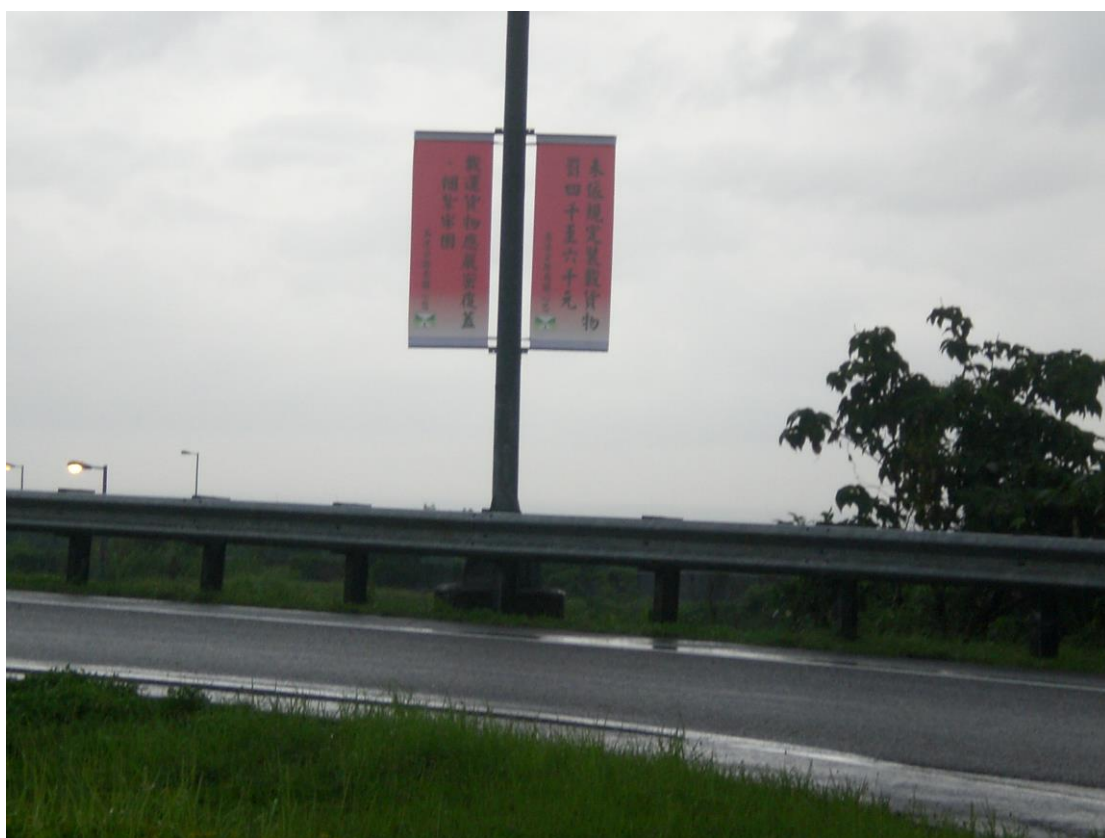
照片-36 古坑服務區聯結車停車場出口處路燈旗
