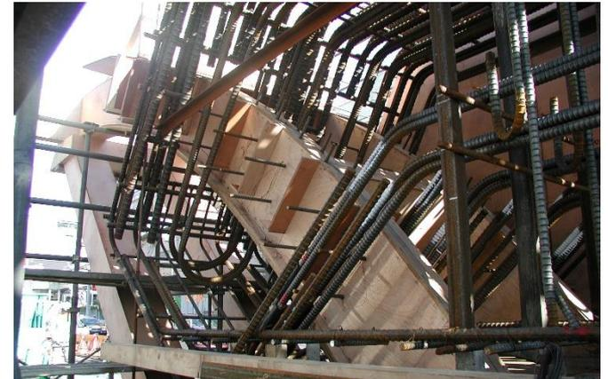
接合部鉄筋型枠組立実験
