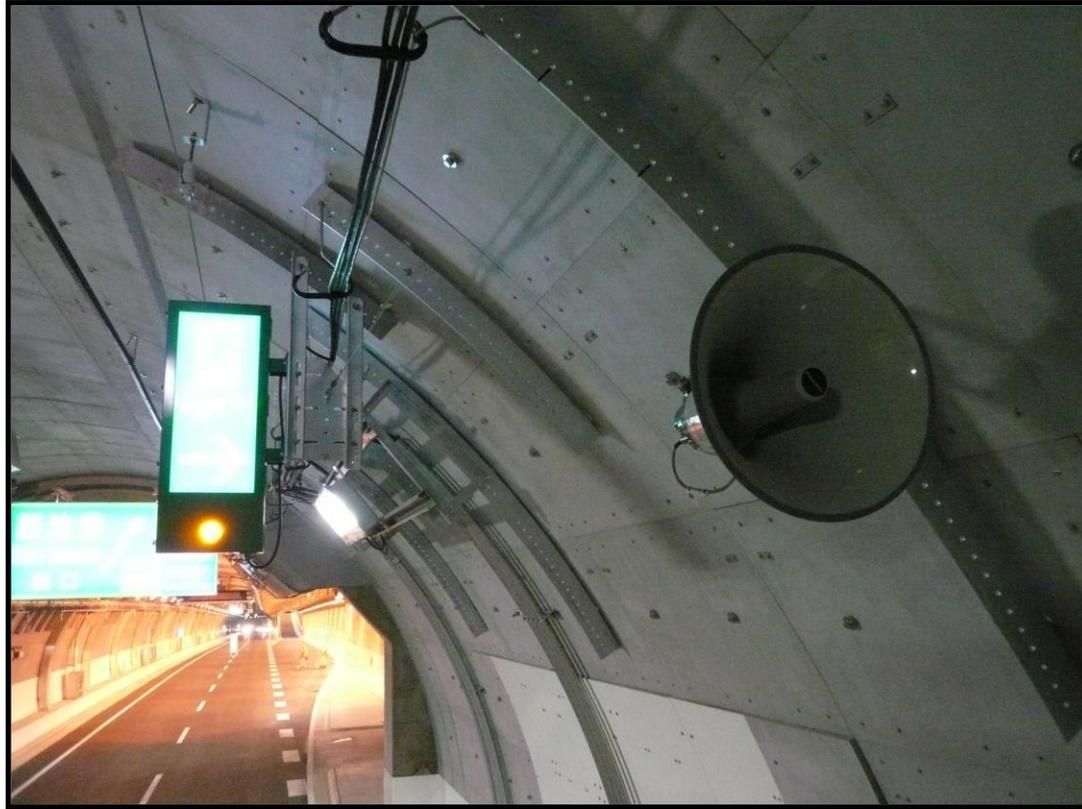
拡声放送スピーカーの設置間隔：約200m
