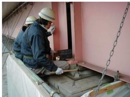
(工事用吊足場設置時に接近目視、触診、打音などにより点検を実施)
