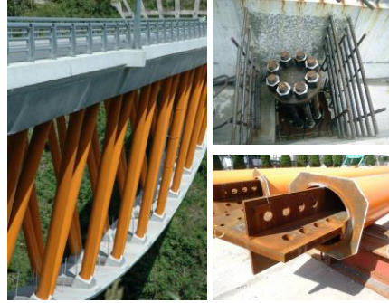
複合トラス橋
