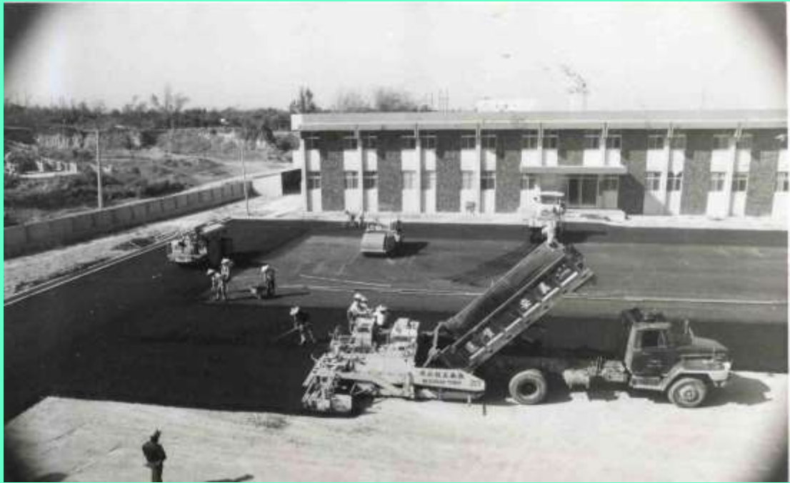
南區養護工程分局舊大樓施工
