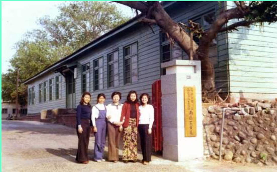
高速公路局南區養護工程分局原始辦公室
