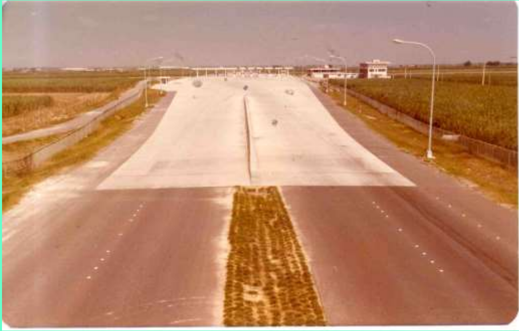
岡山收費站施工中
