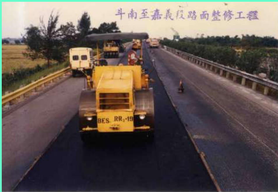
三輪壓路機滾壓
