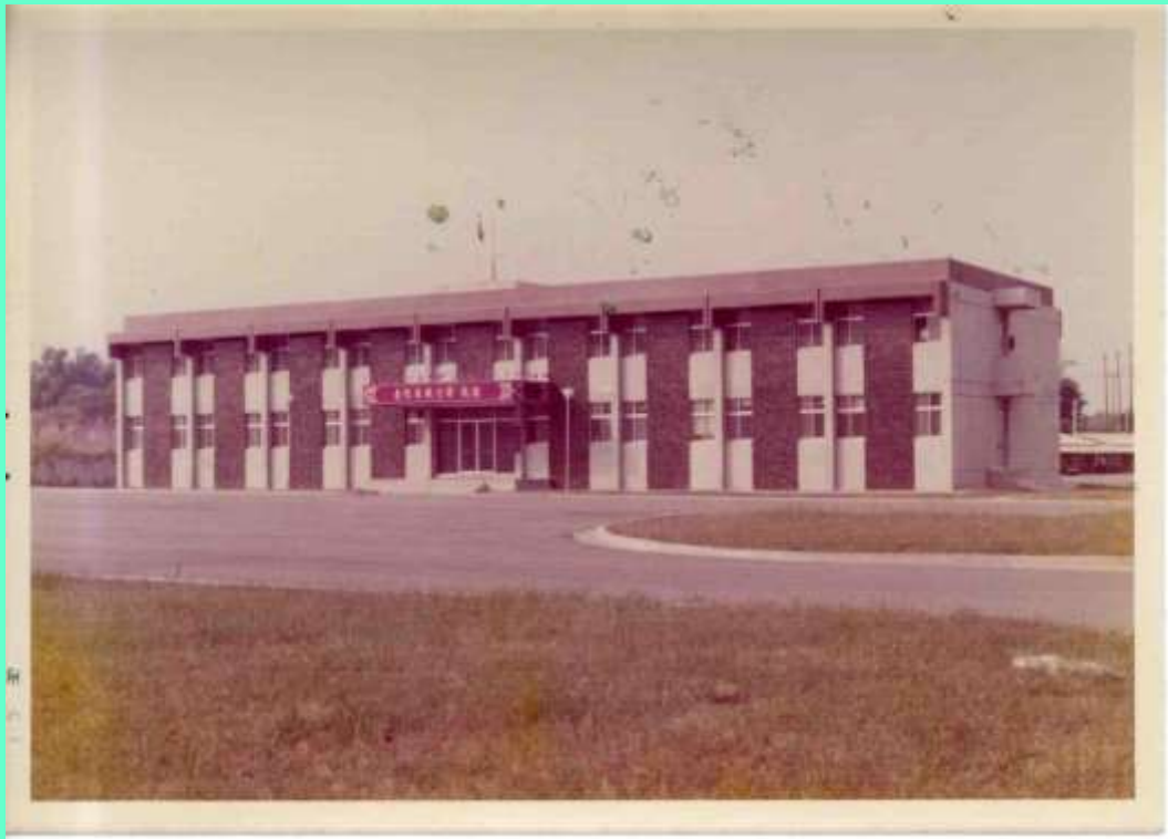
南區養護工程分局完工後
