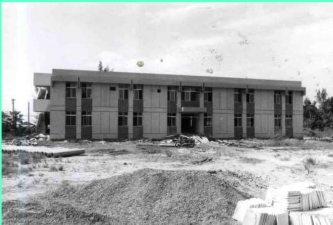
南區養護工程分局舊大樓施工
