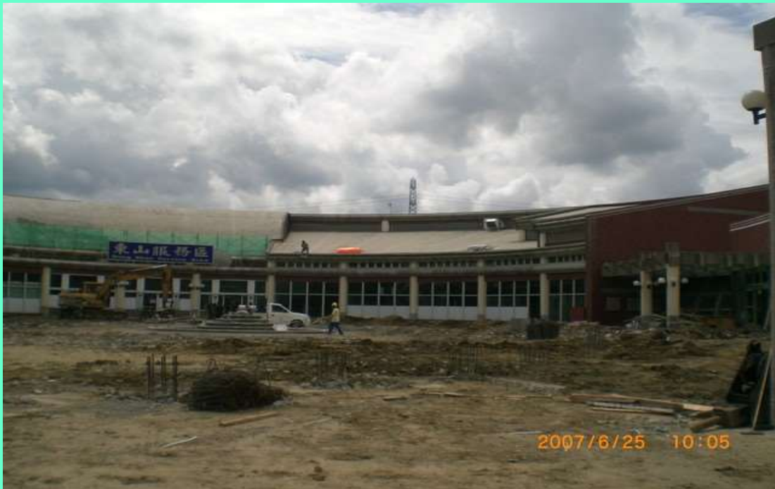
東山服務區施工
