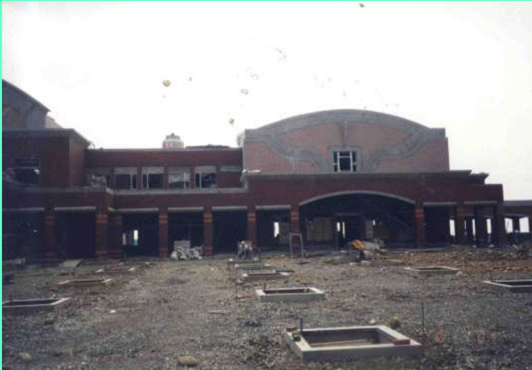
古坑服務區施工
