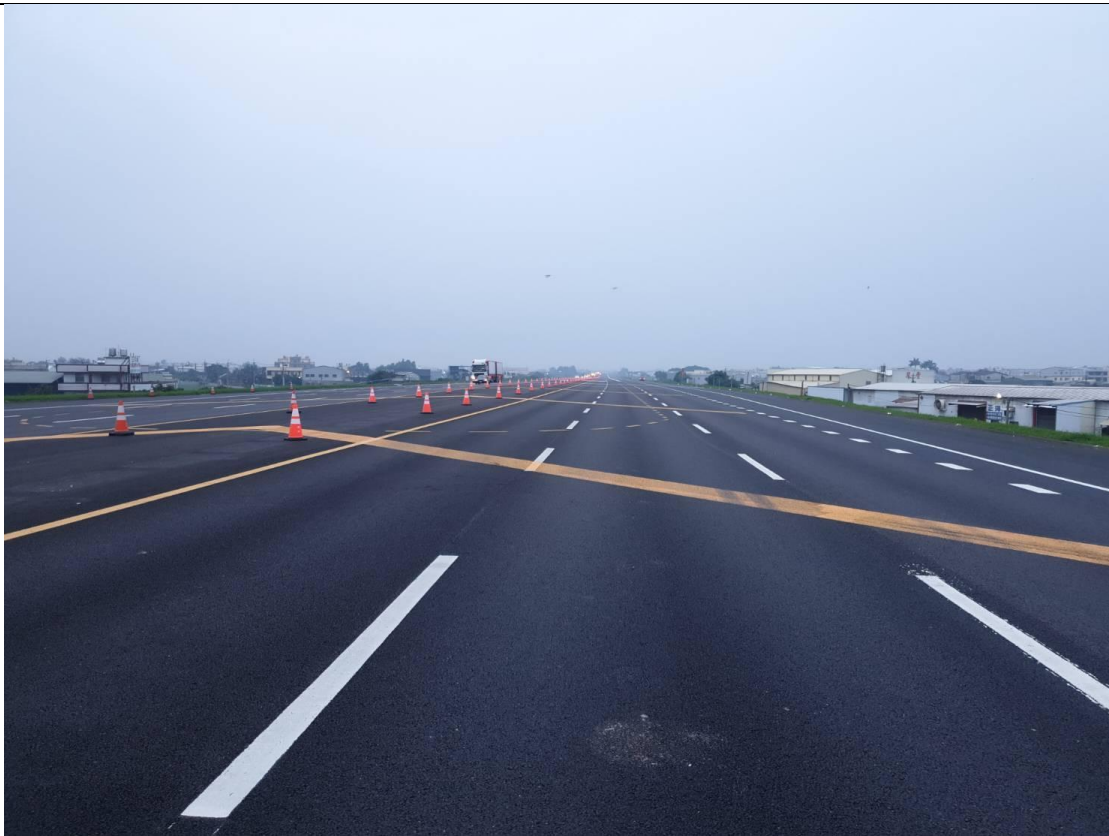
主線護欄吊移，內路肩以交通錐封閉
