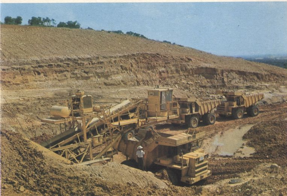
中壢楊梅段挖土工程
