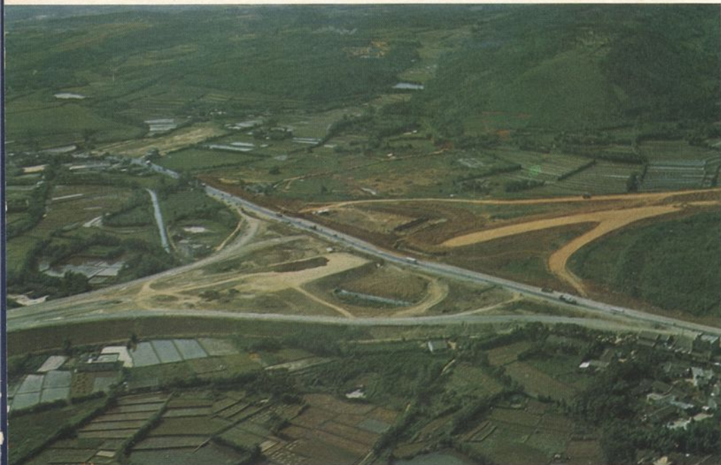
楊梅交流道施工情形
