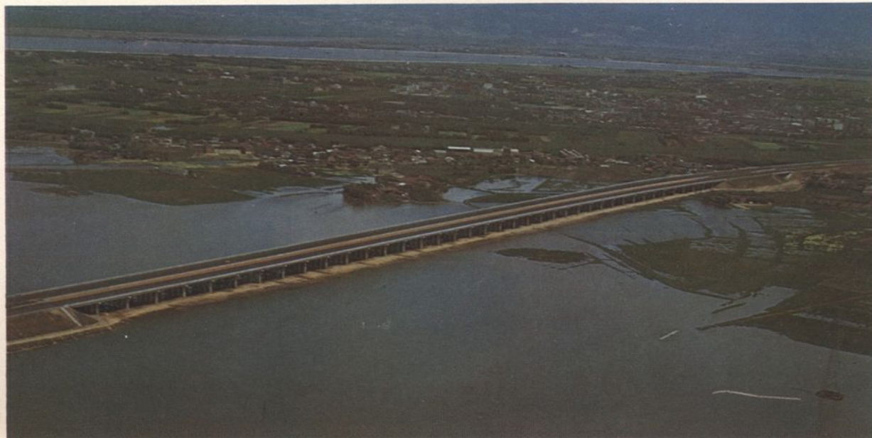
三重泰山間洩洪橋
