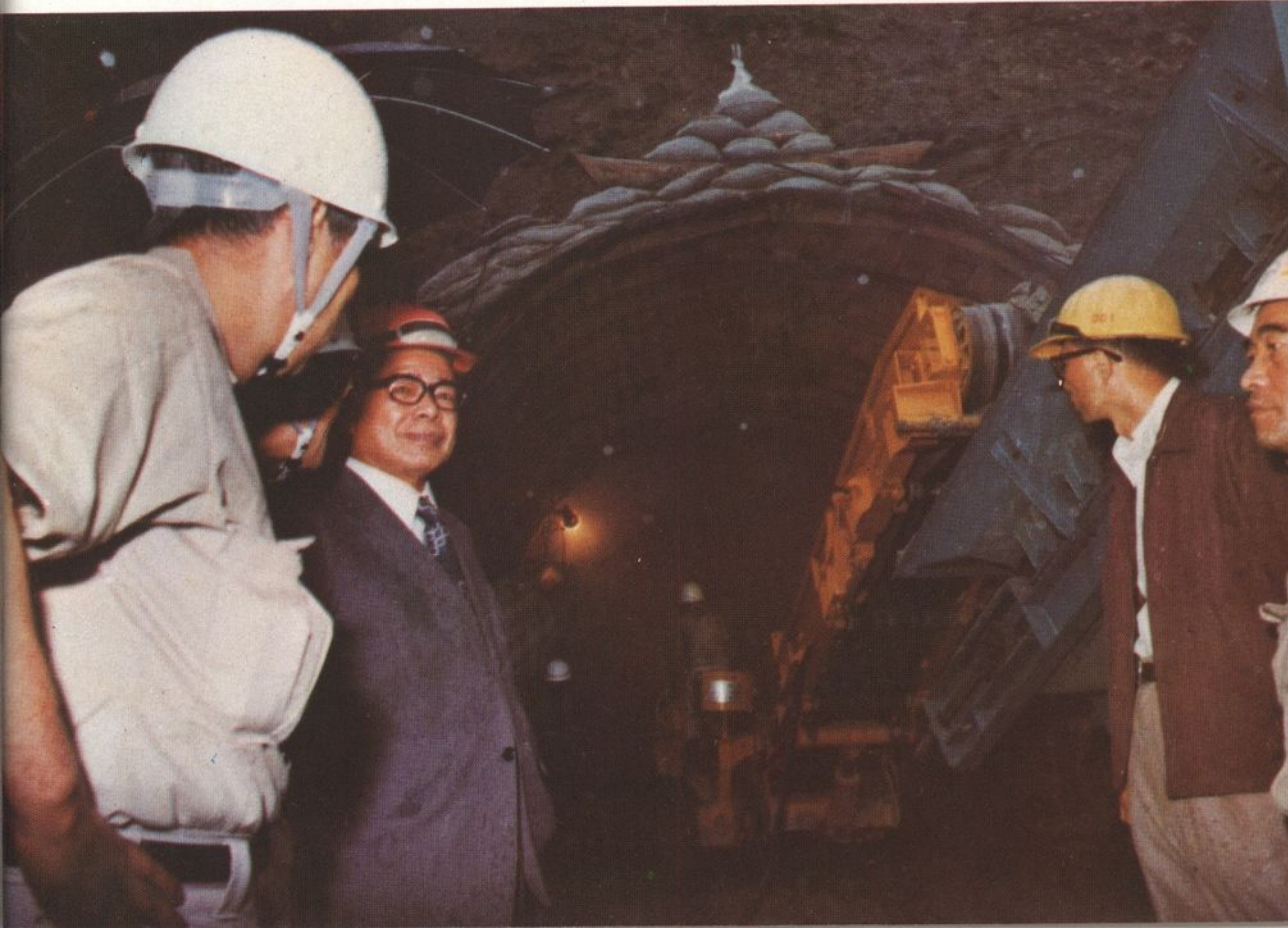
林部長金生巡視大業隧道工程
