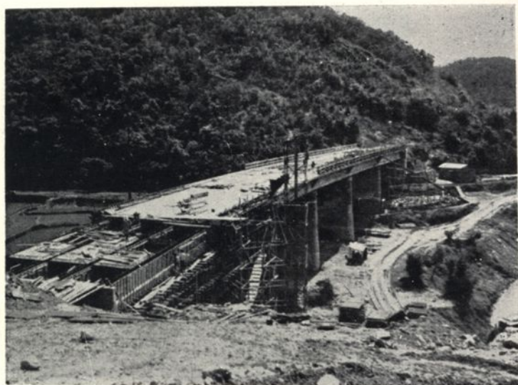
第 8 號橋施工情形
