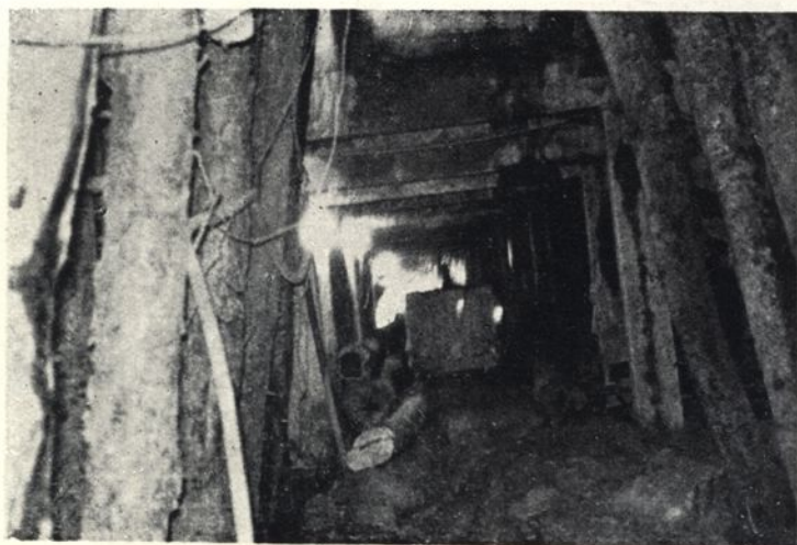
中興隧道開挖道坑
