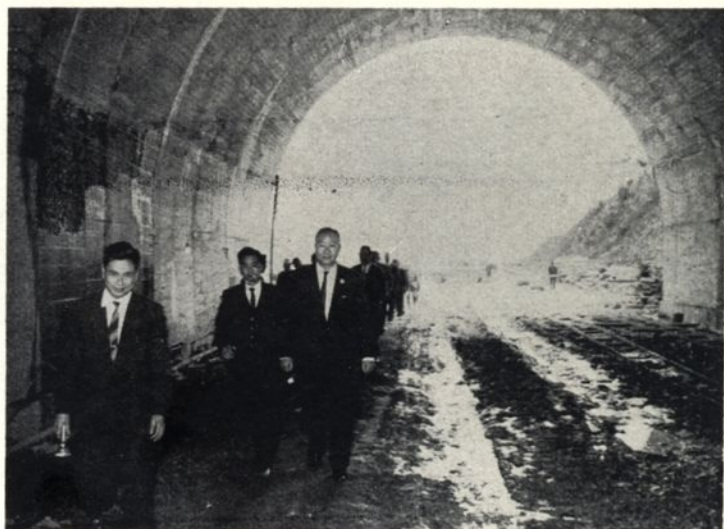
交通處陳處長視察本路施工
