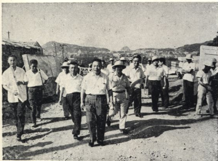
國防部蔣部長視察本路施工
