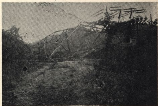
電力公司鐵塔折倒後之情形
