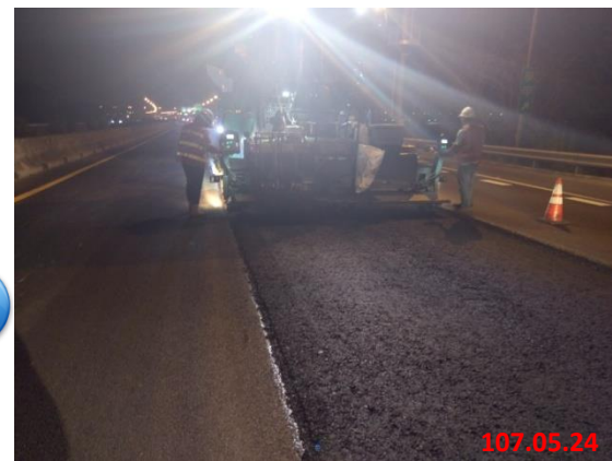
轉爐石瀝青鋪設
