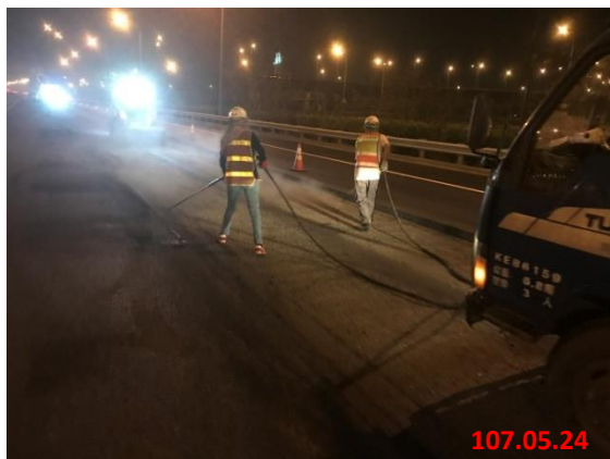
空壓機路面清理
