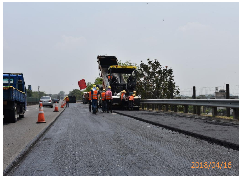
轉爐石鋪築情形
