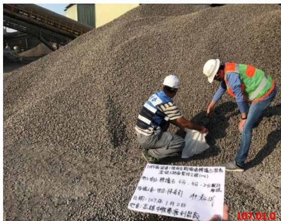
轉爐石粒料取樣
