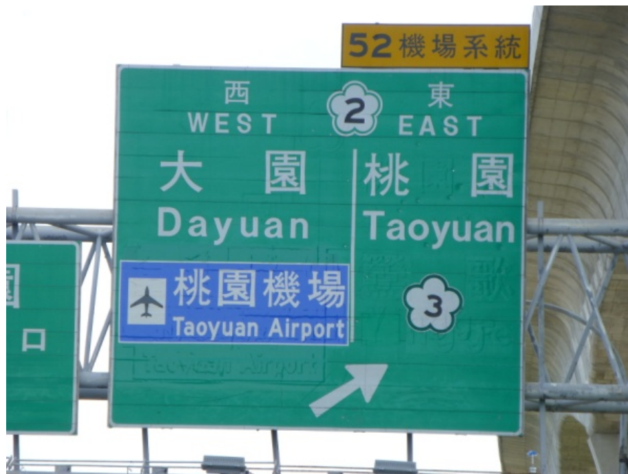
圖 2.2-21 嵌入式出口預告標誌範例（國 1 機場系統交流道）
