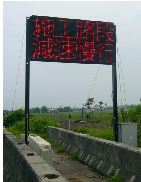
路面設置式移動式 LED 標誌板相片例
