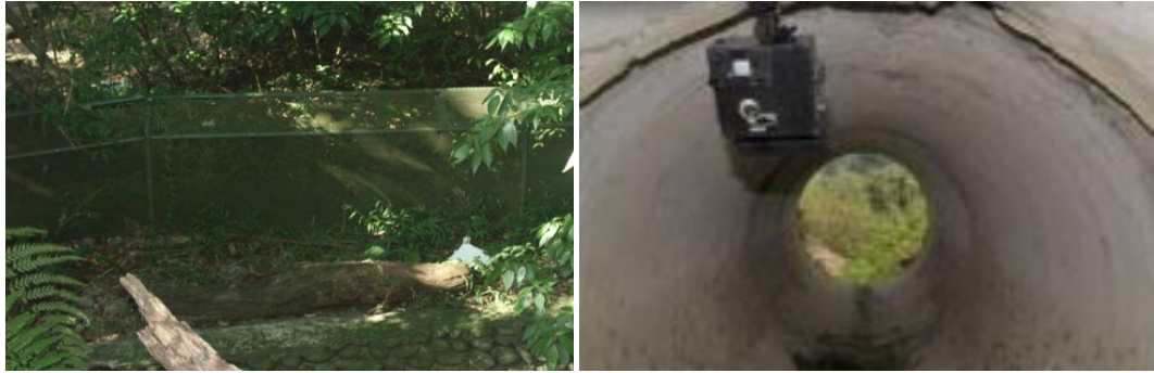
防侵入護網 動物穿越管涵 圖 4.1.10-7 穿越式動物通道及防侵入導引設施示意照片
