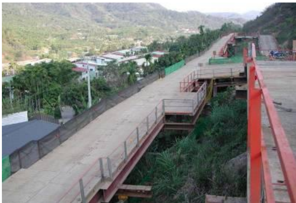
圖 4.1.14-4 國道 6 號南投段施工棧橋案例
