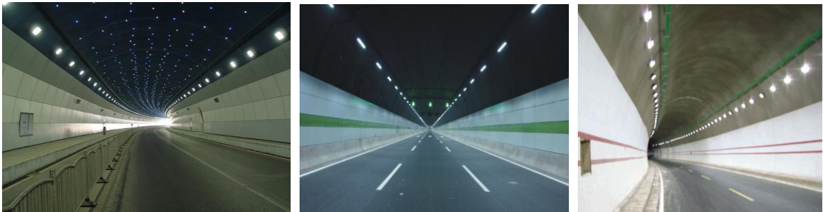
圖 4.1.10-3 隧道塗裝國外案例照片
