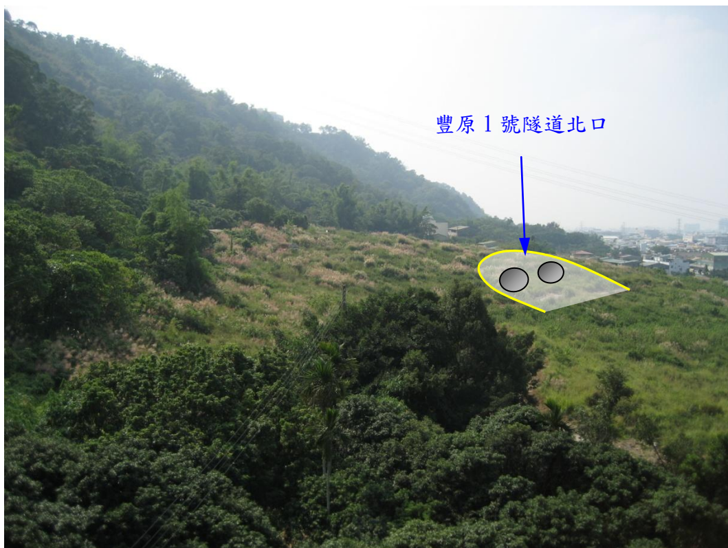
圖 4.1.6-2 豐原 1 號隧道北口狀況
