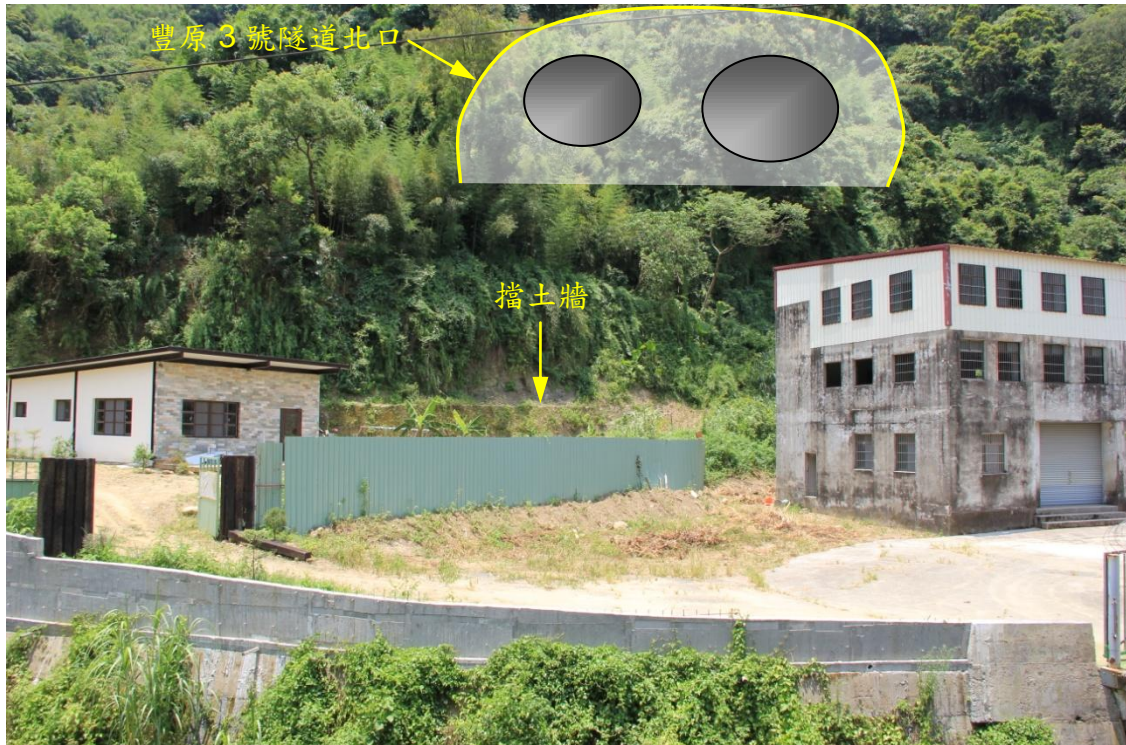
圖 4.1.6-9 豐原 3 號隧道北口現況
