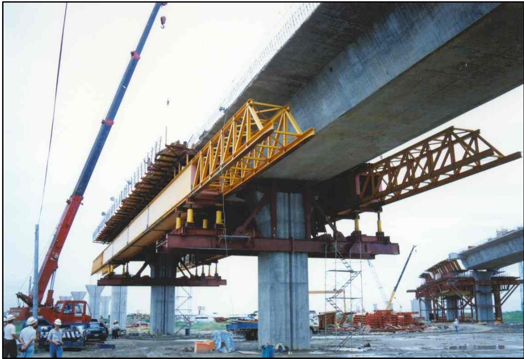
圖 4.1.4-3 支撐先進場鑄逐跨工法
