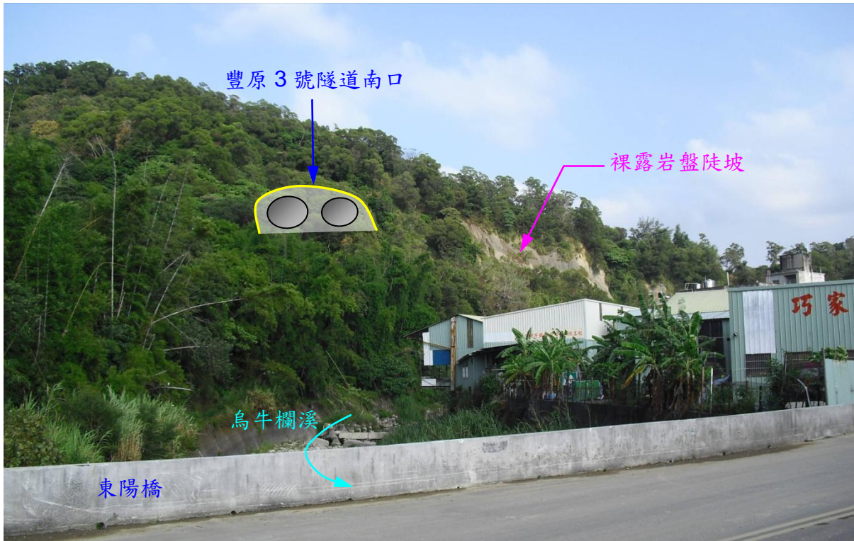
圖 4.1.6-10 豐原 3 號隧道南口位置
