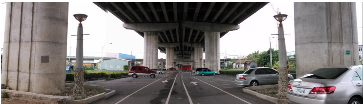
圖 4.1.10-2 國 4 跨后豐鐵道綠廊之橋下現況照片
