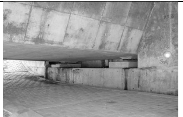
照片 6 A1 橋台結構維修
