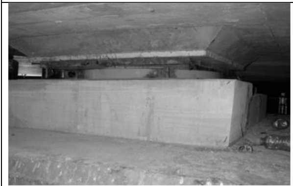
照片 5 盤式支承混凝土墊擴座
