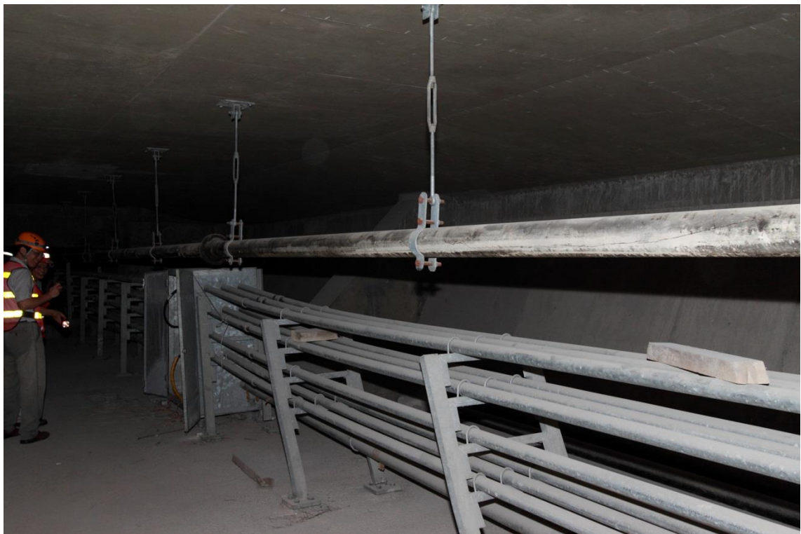
圖 5.5-2 田寮 3 號高架橋管線附掛現況照片
