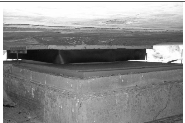
照片 4 P1 橋墩盤式支承更換對正
