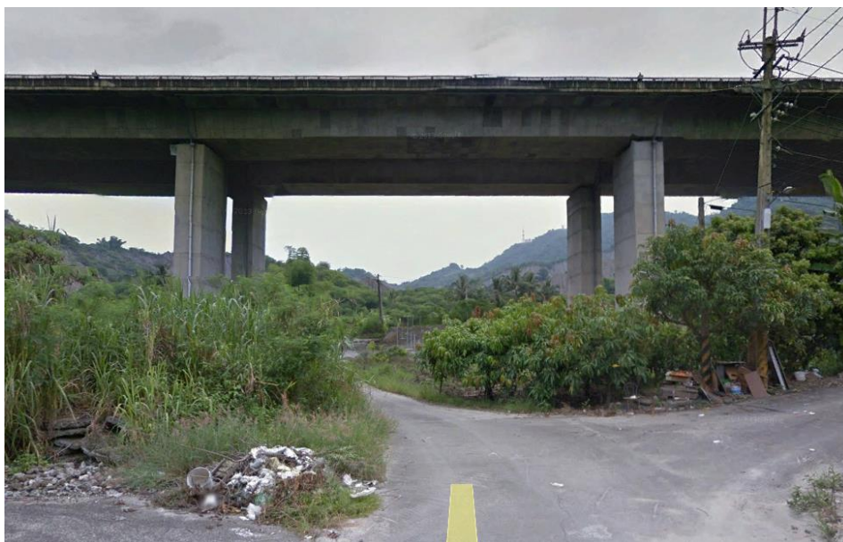
圖 5.4-1 田寮 3 號高架橋下現況產業道路
